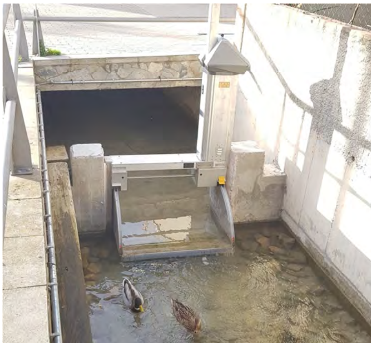
Imatge 10. Comporta del rec d'en Teixidor on es veu el salt de només 4 o 5 centímetres
