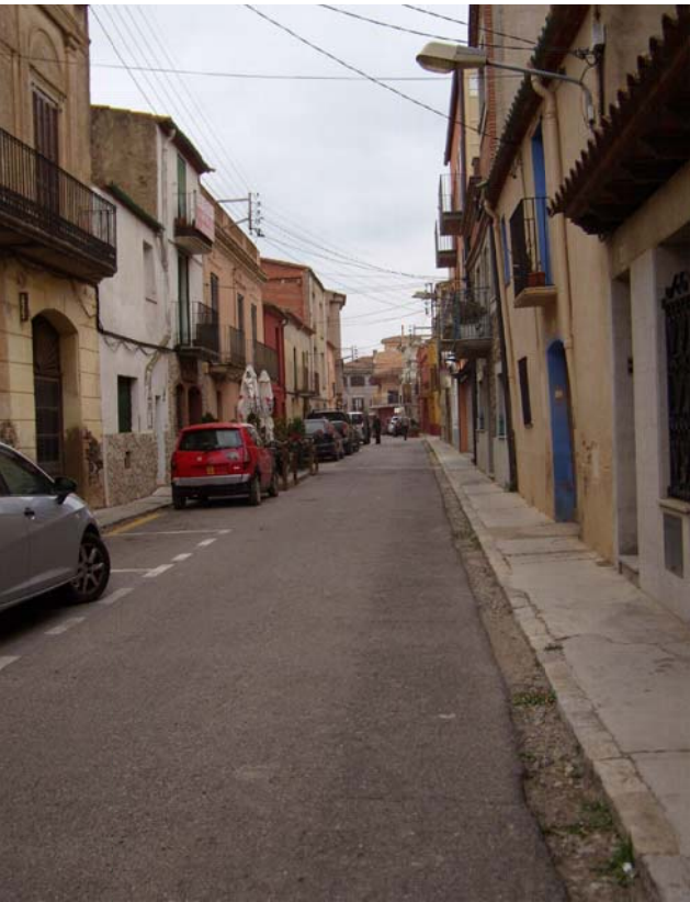
Carrer Gran. Vista Nord
