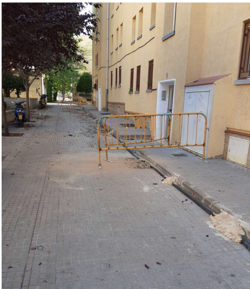
Il·lustració 3: Procés d'instal·lació durant el dia 20 d'agost de canonada provisional. Al finalitzar-lo per la tarda es va restablir el subministrament totalment, de manera temporal, fins a la substitució definitiva de la canonada afectada per l'avaria.
