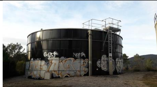
Dipòsit 2 Can Colomer
