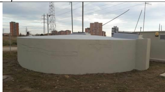
Dipòsits Zona Alta
