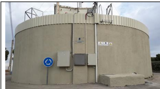
Dipòsit Can Parellada Residencial
