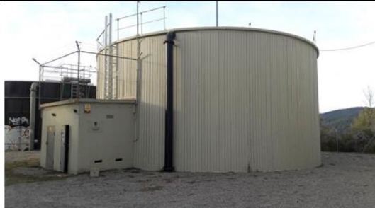
Dipòsit 1 Can Colomer
