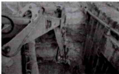
DEMOLICIÓN MECÁNICA EN ZANJA
