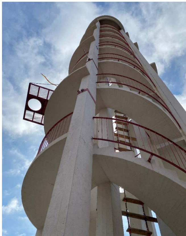
Torre de pràctiques
