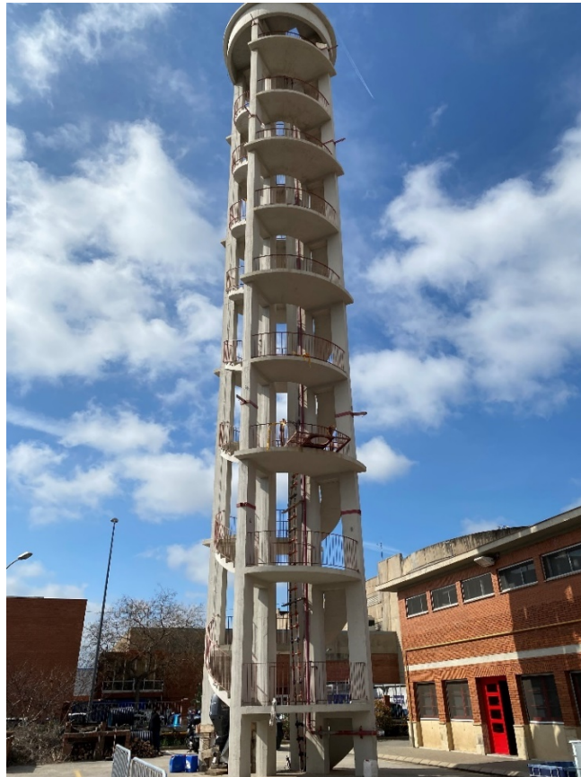
Torre de pràctiques
