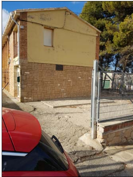
FAÇANA LATERAL COSTAT ACCÉS FINESTRA A CANVIAR
