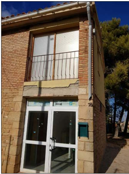
ACCÉS ZONA A REFORMAR BALCONERA I BARANA A CANVIAR/ELIMINAR
