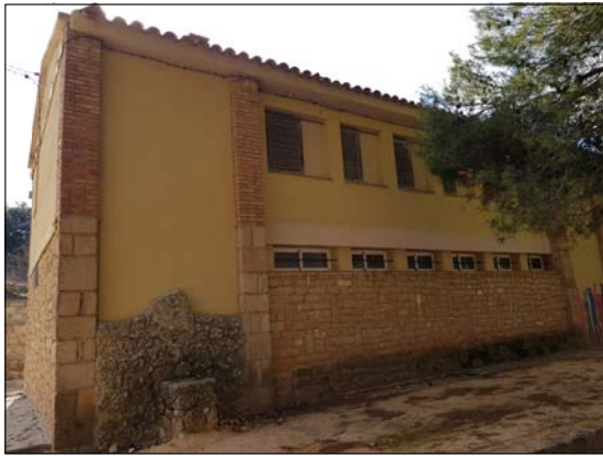
FAÇANA POSTERIOR NETEJA DE PEDRA A LA ZONA INFERIOR CANVI DE FINESTRES PIS SUPERIOR 1er TRAM (6 uts)
