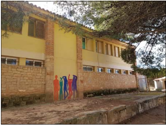
FAÇANA ACCÉS NETEJA DE PEDRA A LA ZONA INFERIOR
