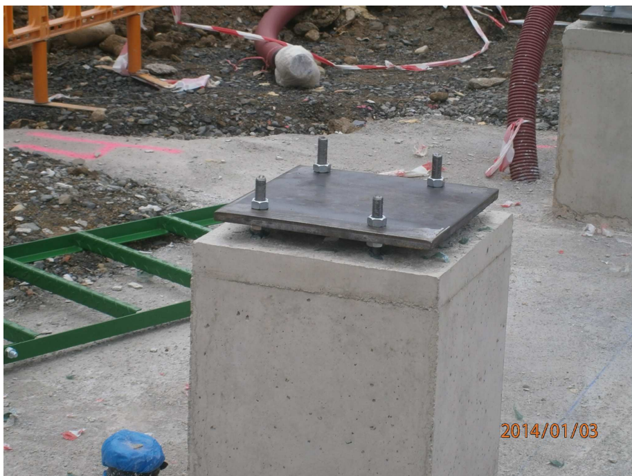
Detall de la placa d'ancoratge.
