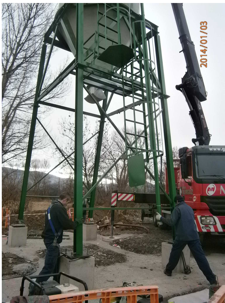
Imatge del muntatge de la Sitja de 35Tn a principis de l'any 2014
