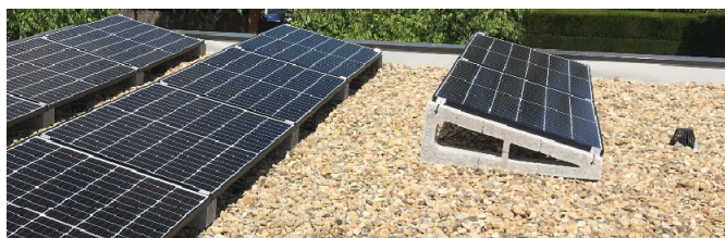
Fig. 7.2. Estructura de subjecció Solarbloc.
