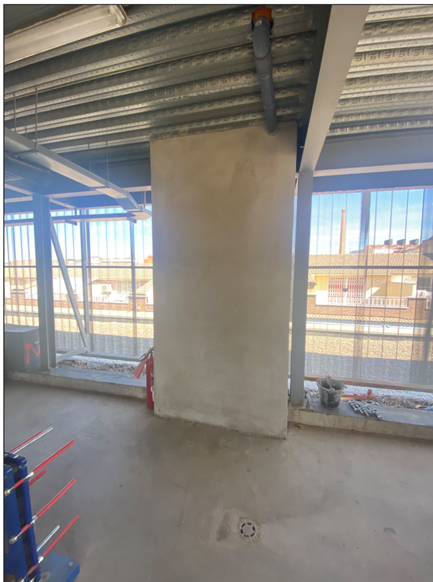
Fig. 4.4. Situació de l'Inversor
