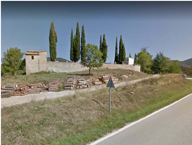
Vista des de l'arribada de la carretera
