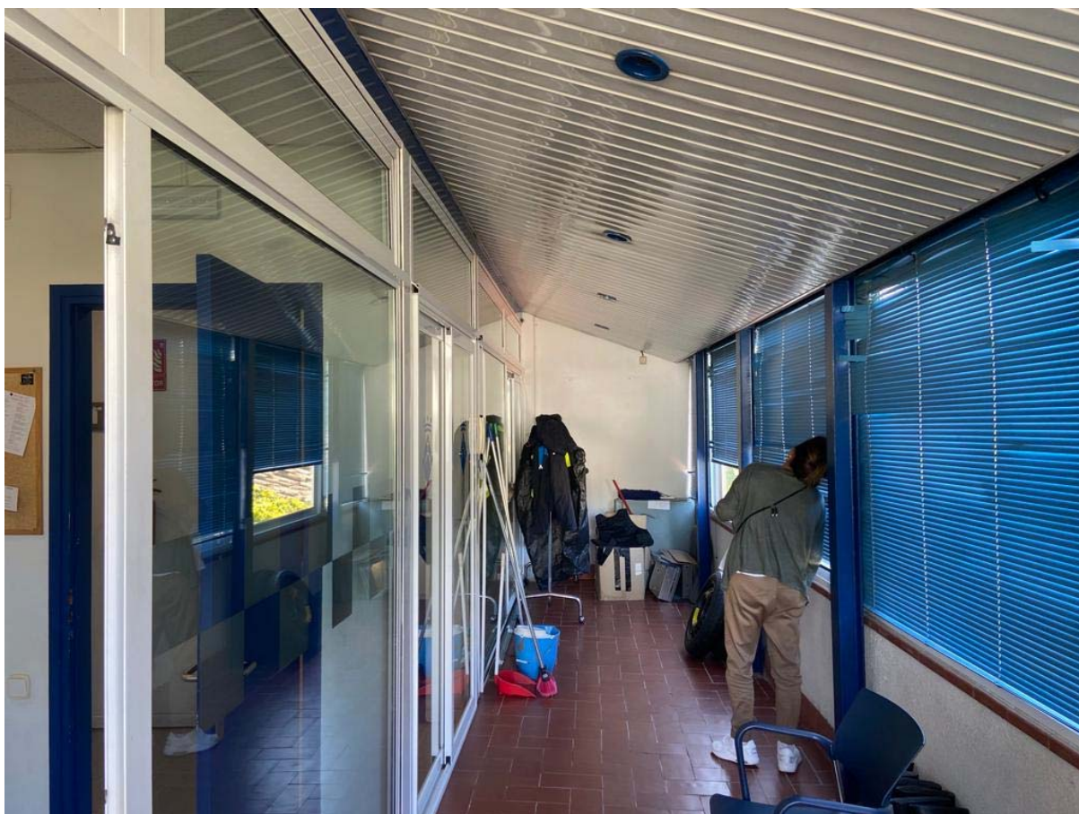
Zona terrassa coberta p1
