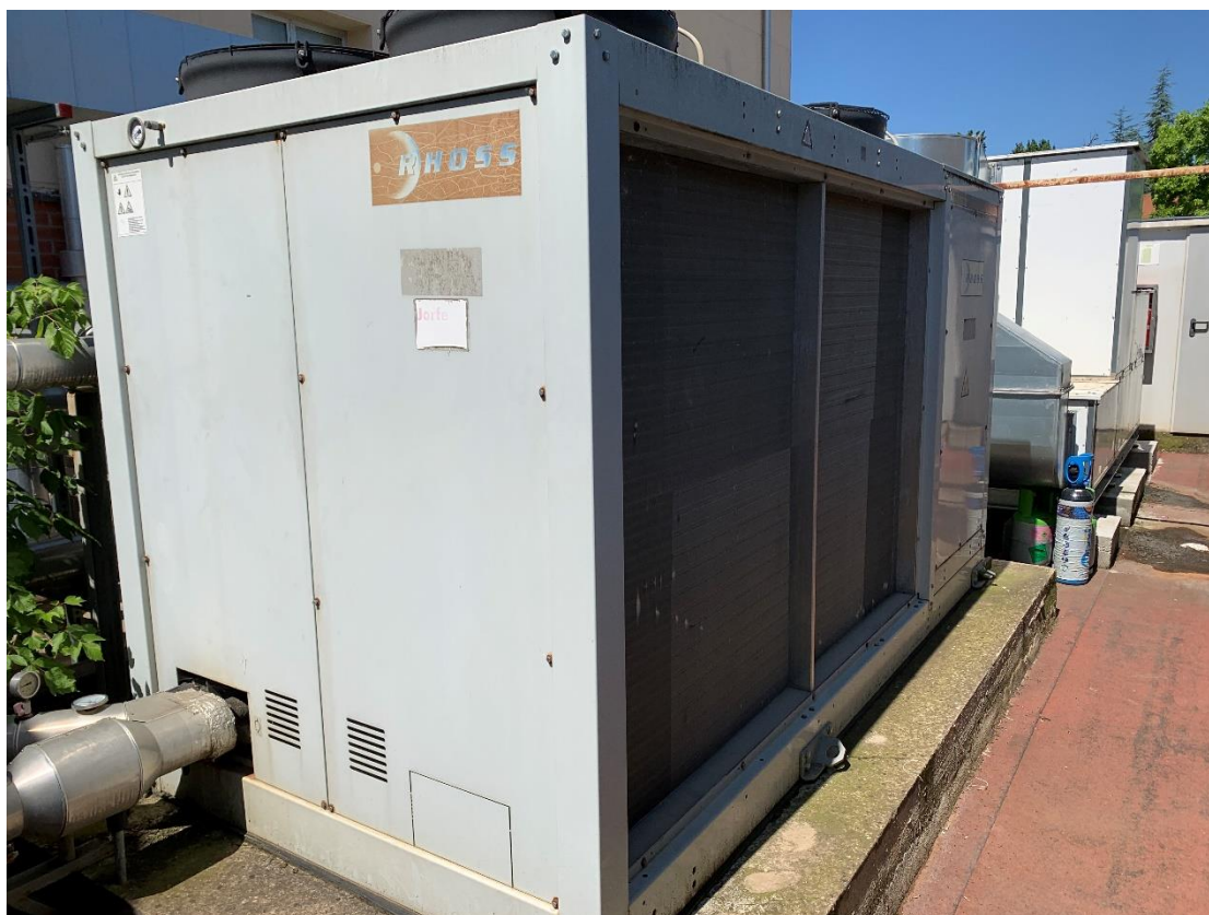
Fotografia 2. Planta refredadora a substituir (1)
