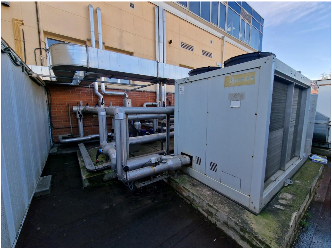
Fotografia 4. Planta refredadora a substituir – canonades connexió instal·lació existent (1)
