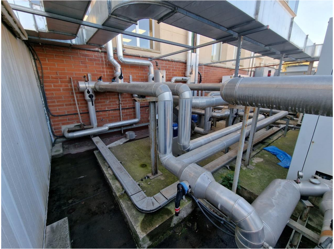
Fotografia 5. Planta refredadora a substituir – canonades connexió instal·lació existent (2)
