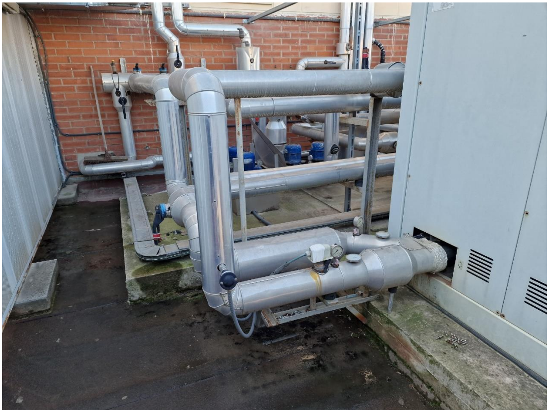
Fotografia 6. Planta refredadora a substituir – canonades connexió instal·lació existent (3)
