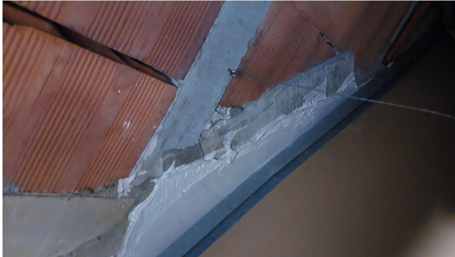
Forjats existents. Biguetes unidireccionals i revoltons ceràmics.
