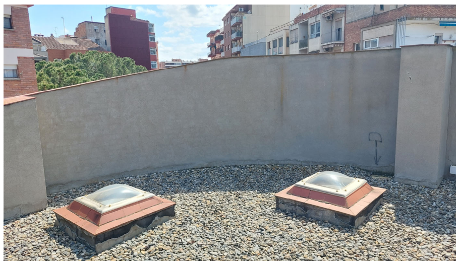
Vista general de la coberta, punt de sortida del tub.
