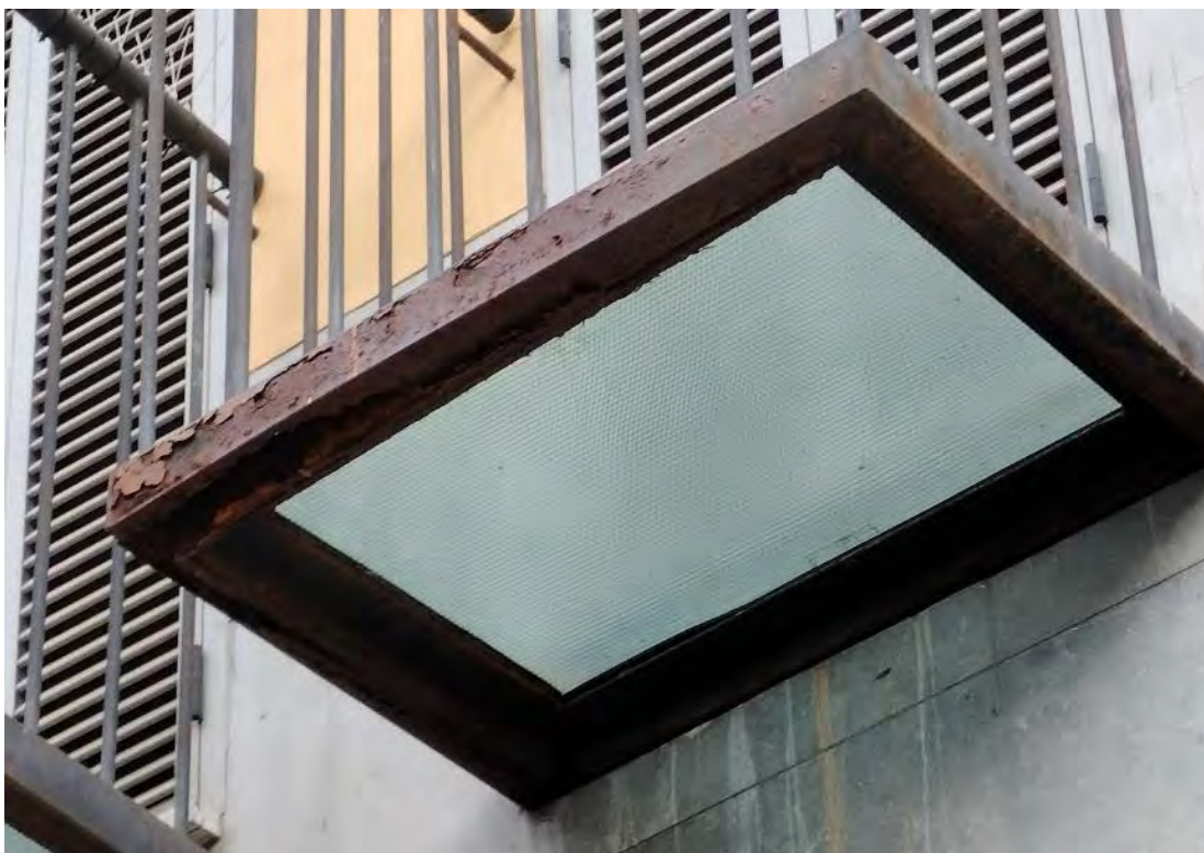
Habitatge 1-2. Cara inferior. Molt deteriorat, pèrdua de secció
