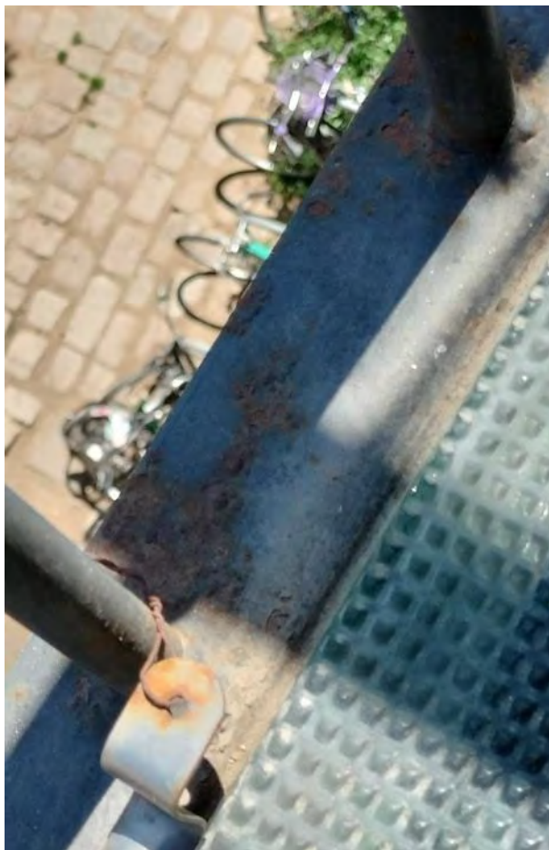
Habitatge 3-3. Cara superior. Inici d'oxidació, sense laminar ni pèrdua de secció
