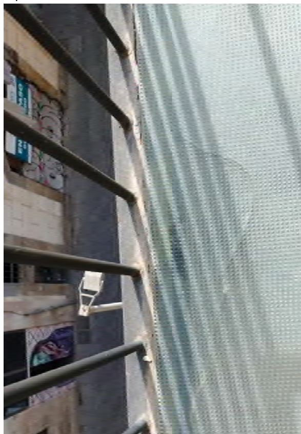
Habitatge 3-4. Cara superior inici d'oxidació en junta amb paviment de vidre. Vidre esquerdat
