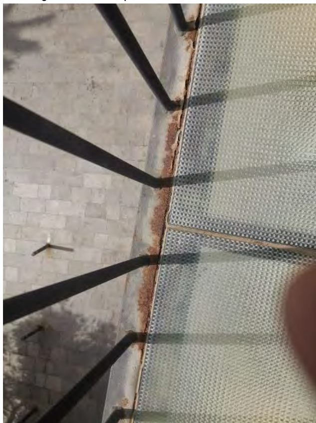
Habitatge 3-4. Cara superior inici d'oxidació en junta amb paviment de vidre. Vidre esquerdat
