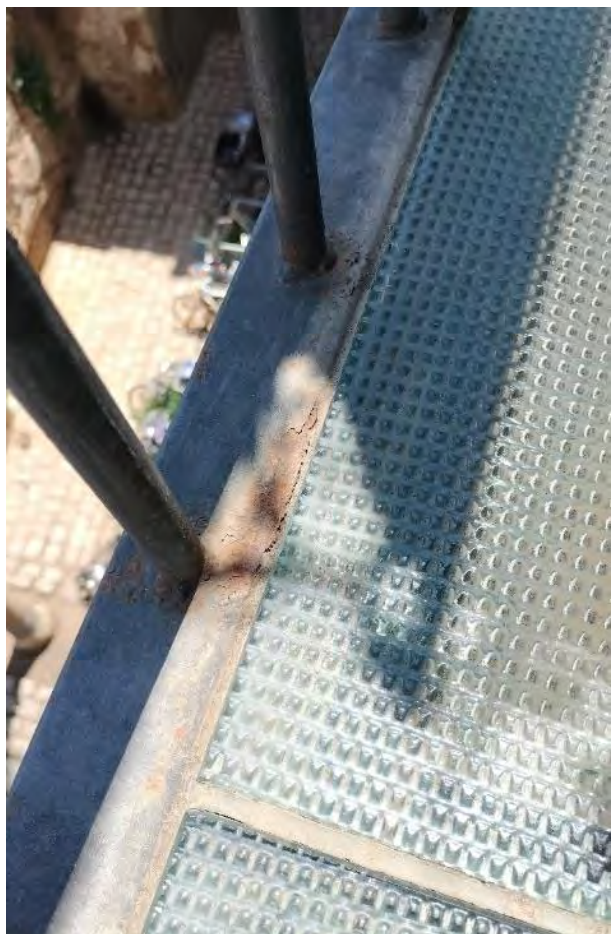
Habitatge 3-3. Cara superior. Inici d'oxidació, sense laminar ni pèrdua de secció
