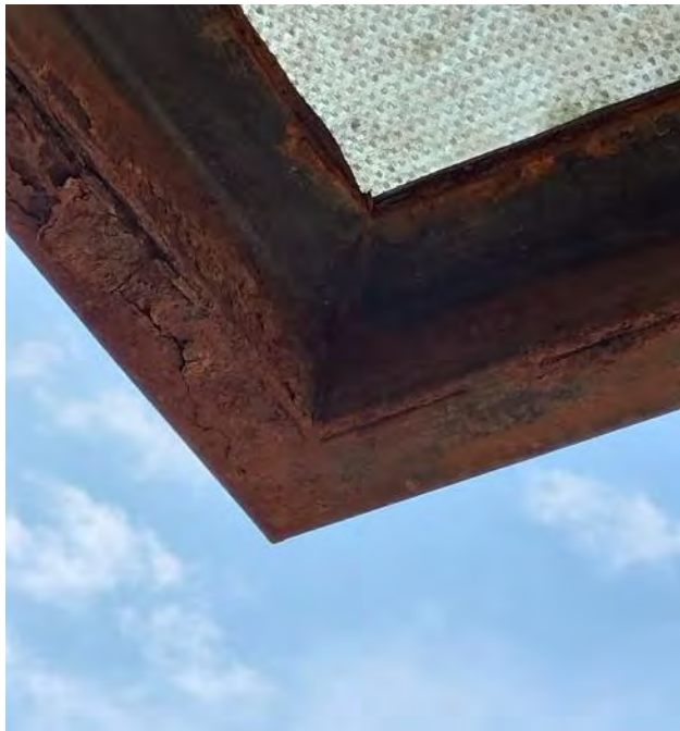
Habitatge 4-1. Cara inferior. Molt deteriorat, pèrdua de secció
