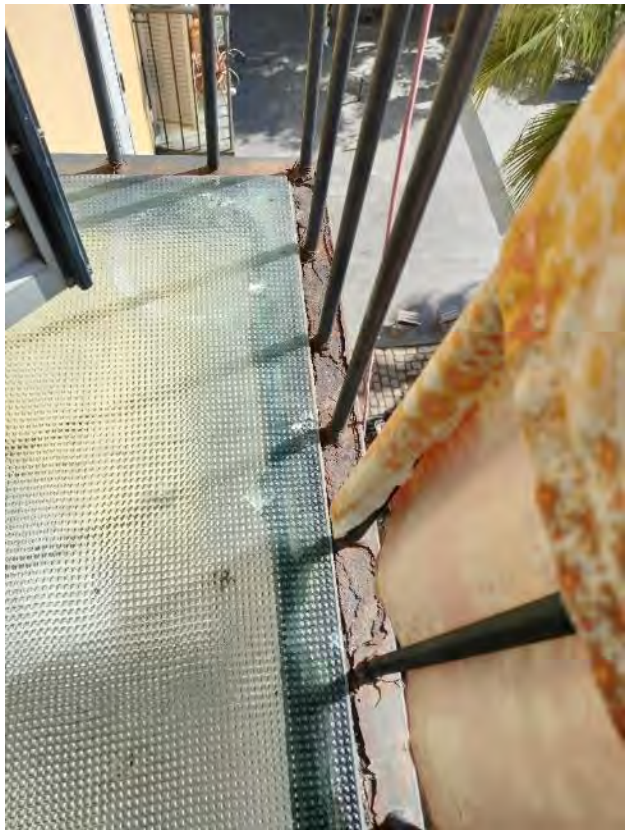
Habitatge 4-1. Cara superior. Molt deteriorat, pèrdua de secció
