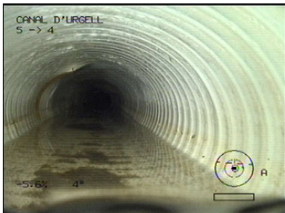
Fotografia: 39a, 00:00:00 1m, Inicio de la inspecció
