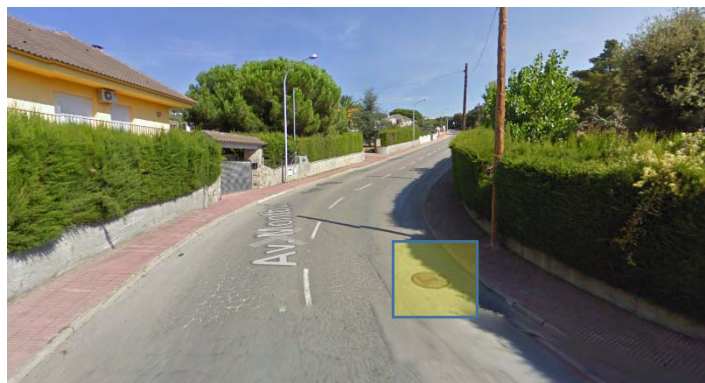
Foto 3. Tapa de registre càmera telecomunicacions
