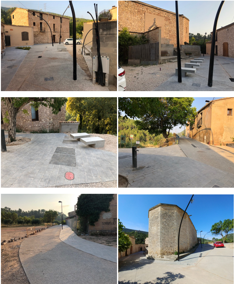
Imatges de l'obra urbanitzadora fase 1
