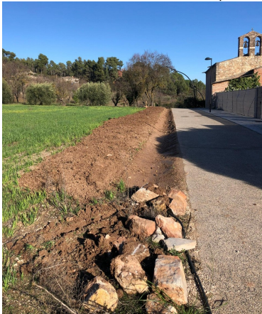
Reperfilat base talús i cuneta
