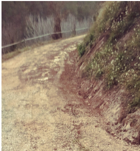
Reperfilat base talús i cuneta
