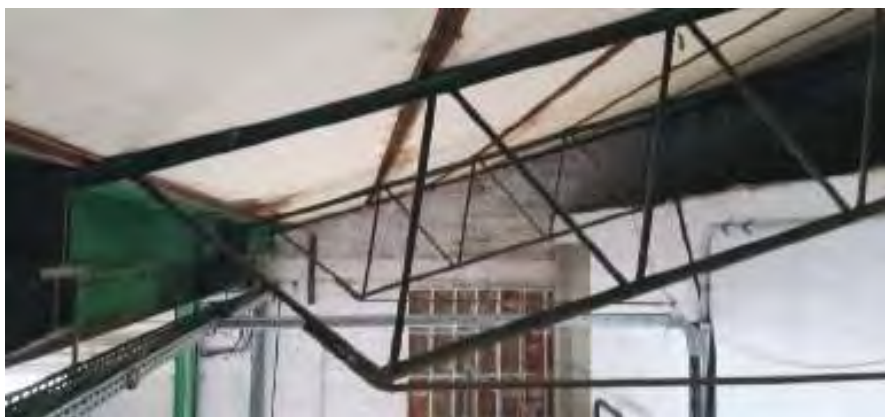
Imatge 8, detall canal interior, \Omega , aïllaments i encavallada.
