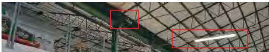
Imatge 15, detall de palometes i llumeneres a desmuntar
