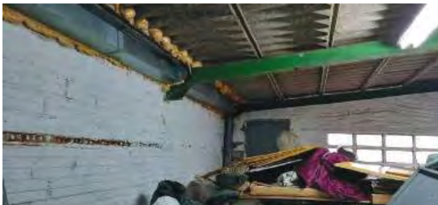
Imatge 10, interior annex 1
