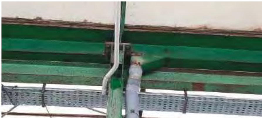
Imatge 13, detall de la canal interior amb el baixant de PVC
