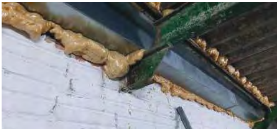
Imatge 11, detall recolzament jàsseres tallades i cartel·les
