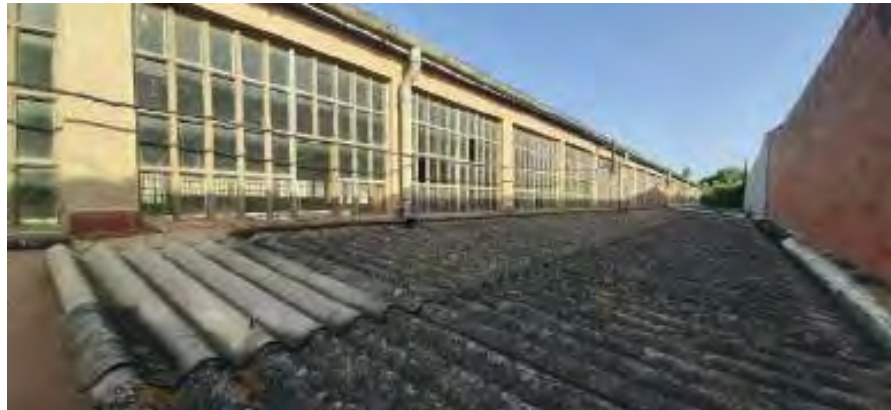
Imatge 5, coberta de fibrociment de l'edifici annex i canals laterals amb la mitgera.
