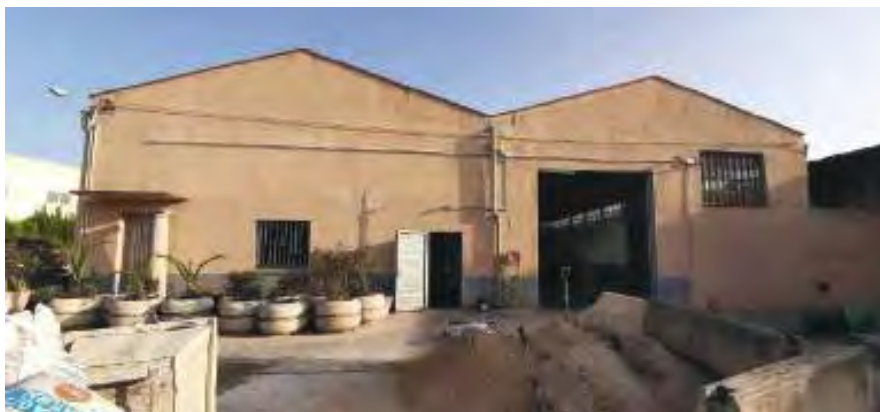
Imatge 1, vista de la façana Sud-Est, amb les dues tramades de la nau principal i a la dreta la part corresponent a l'edifici annex.
