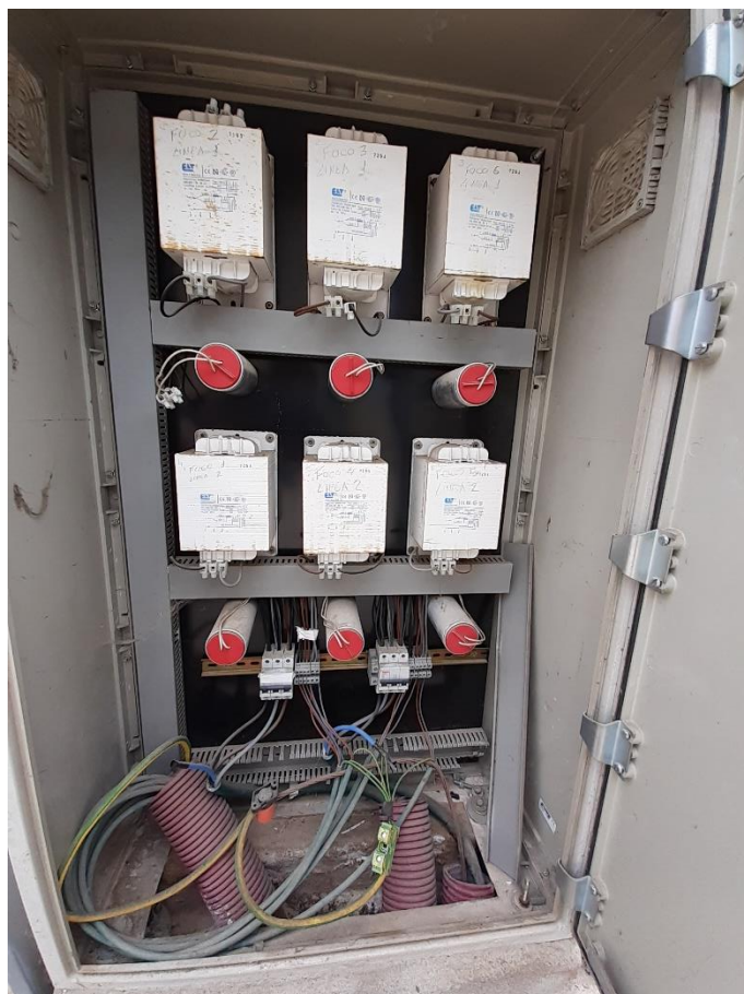
Imatge 15. Quadre de drivers a peu de torre del camp annex
