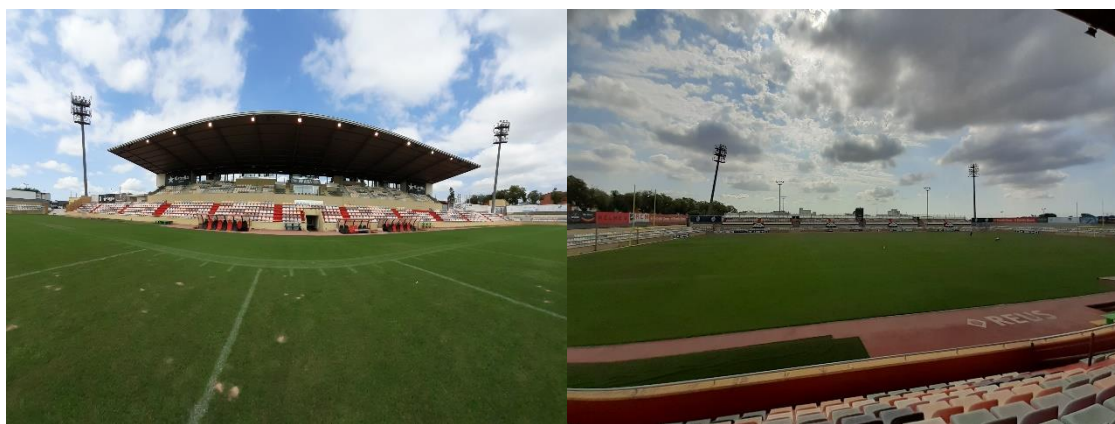
Imatge 18. Vistes de l'estadi municipal
