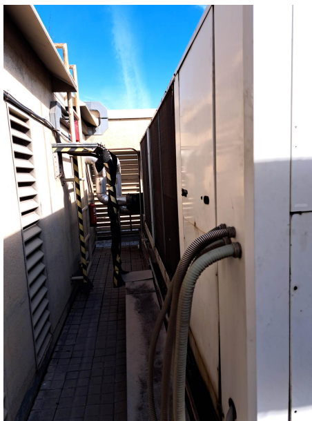
Paret del nou recorregut de la safata elèctrica
