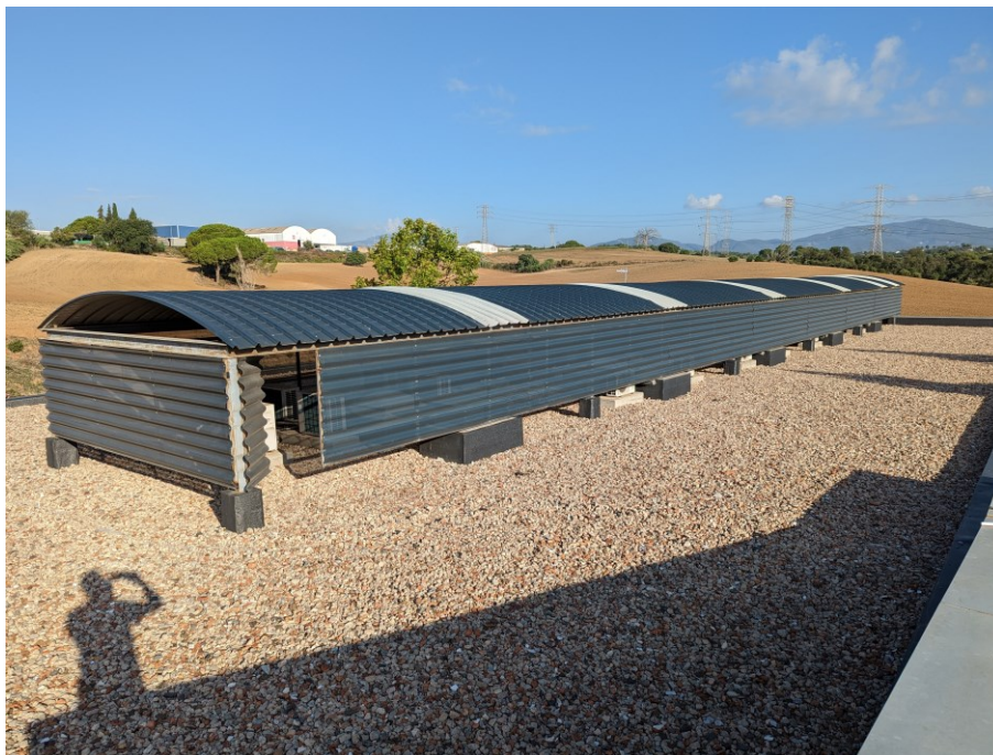
Fotografia 5: Coberta instal·lació panells fotovoltaics
