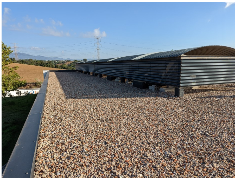
Fotografia 6: Coberta instal·lació panells fotovoltaics
