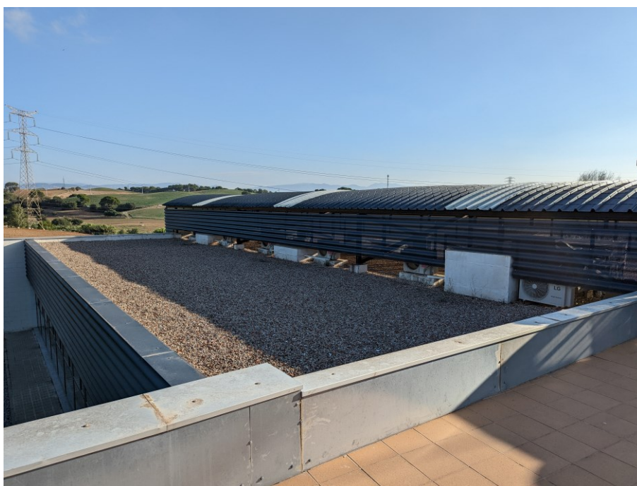
Fotografia 4: Coberta instal·lació panells fotovoltaics
