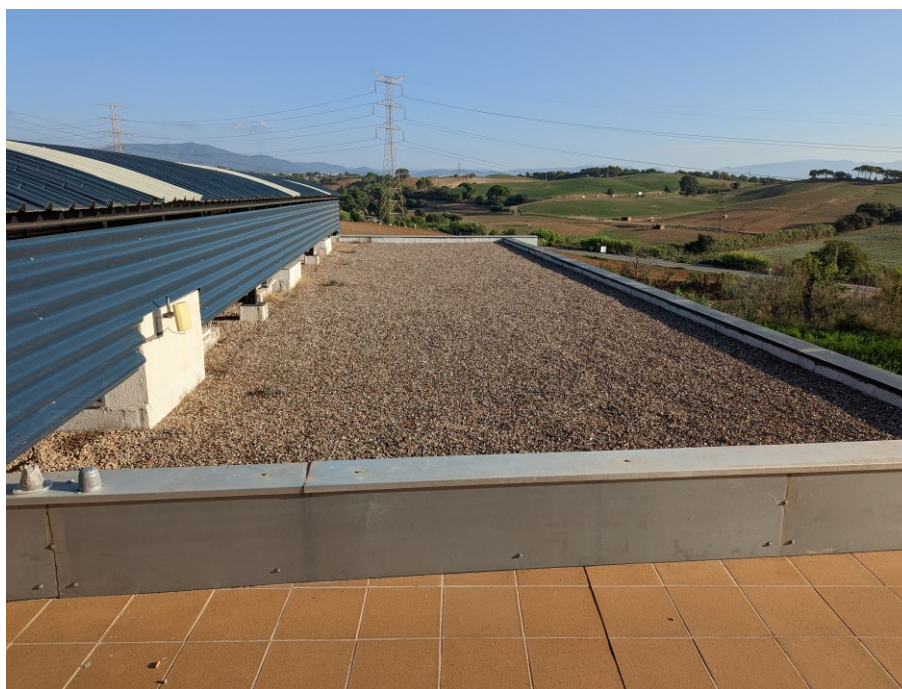
Fotografia 3: Coberta instal·lació panells fotovoltaics
