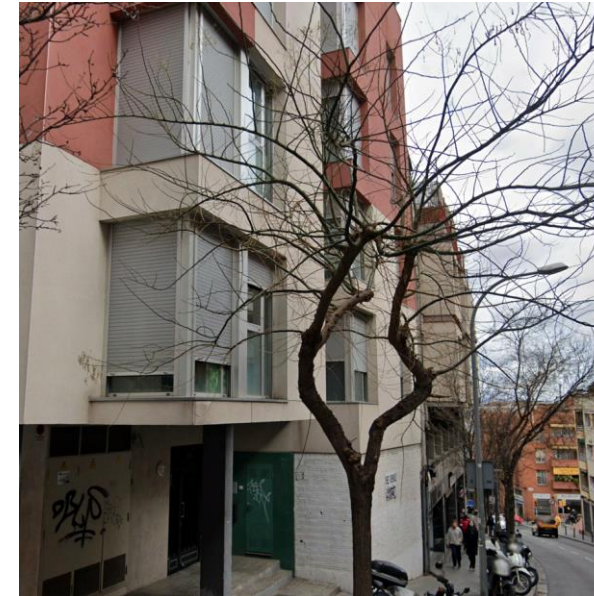
Imatge general de l'edifici
