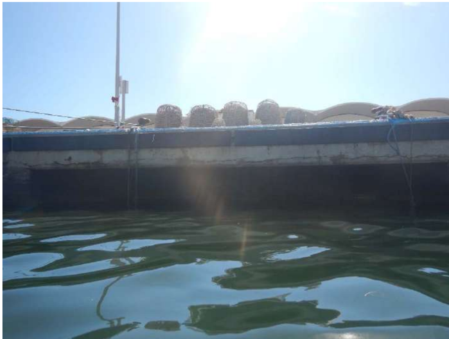
Imatge 3.4. Vista frontal del moll. S'aprecia esquerda a la part inferior de la biga cantell en tota la seva longitud.
