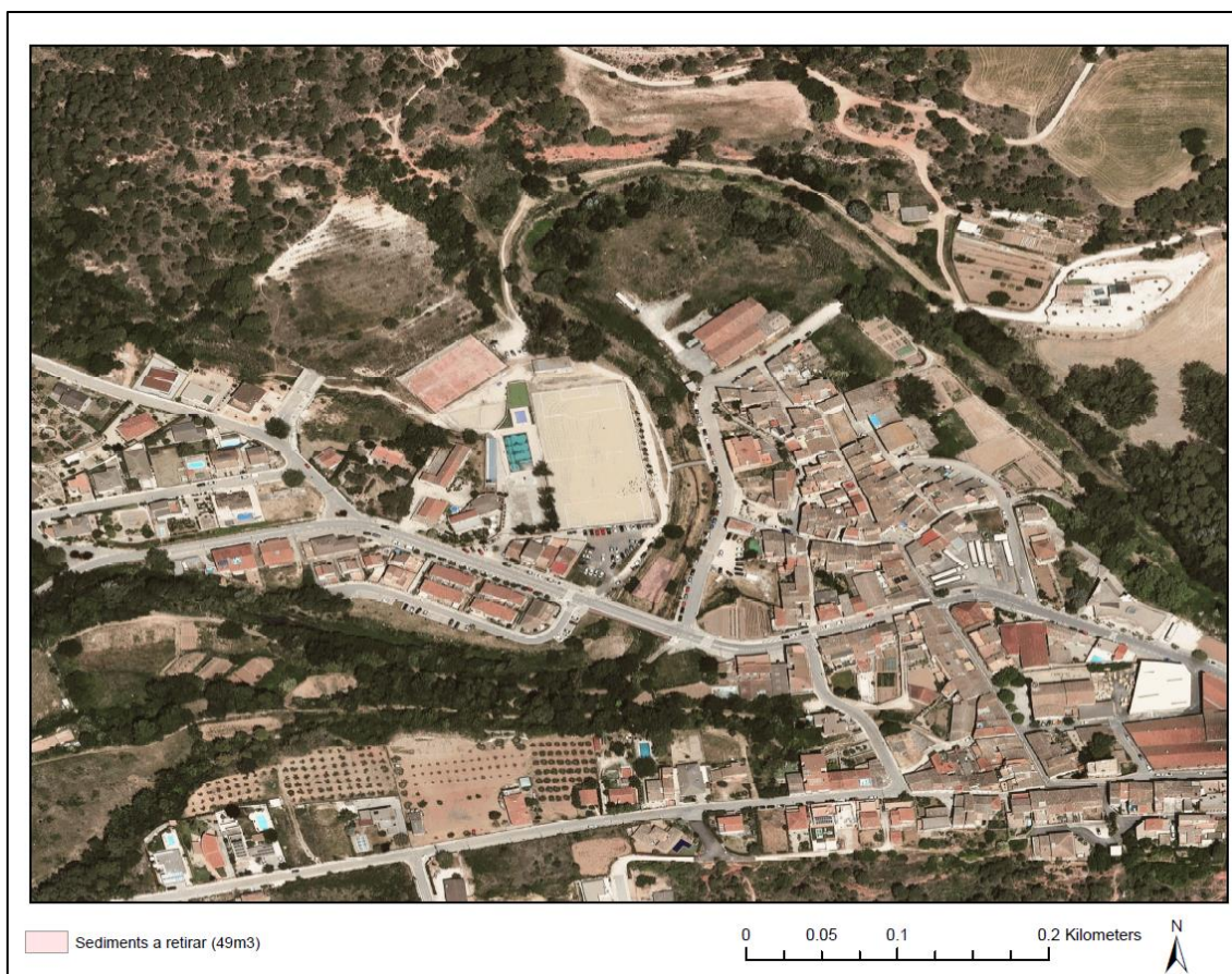
Il·lustració 9. Localització dels sediments acumulats després dels treballs de desbloqueig del Pont de la BV2131. Elaboració pròpia.
