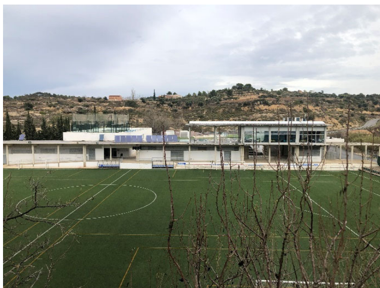
Coberta grades camp de futbol, coberta bar i estructura a base de bigues de formigó
