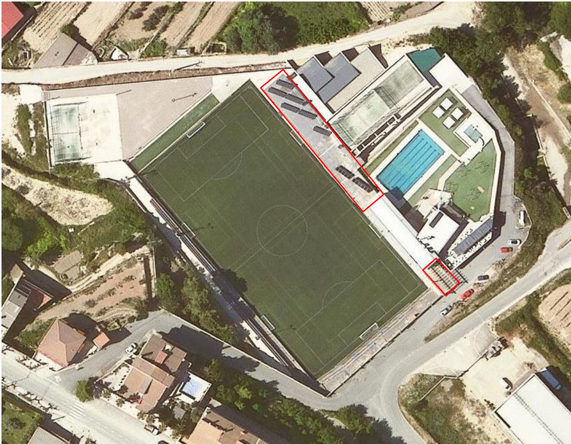
Vista general de la zona per camp fotovoltaic sobre coberta del poliesportiu municipal de Batea
