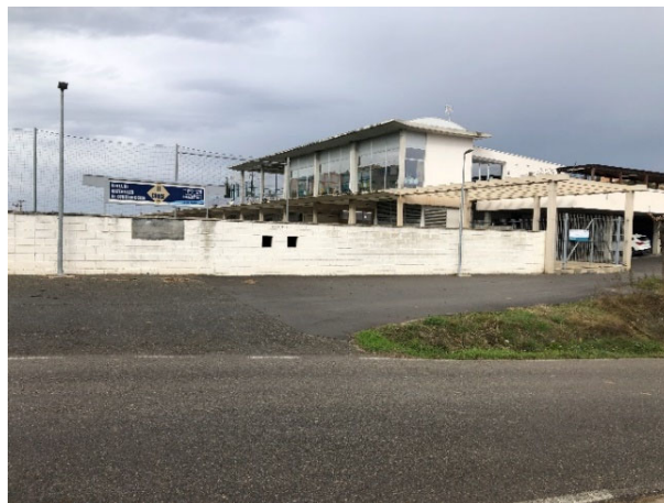
Estructura a base de bigues de formigó
