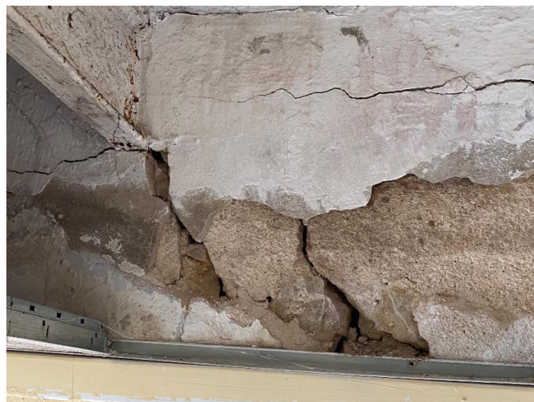
Il·lustració 14.- esquerda a l'obra de fàbrica
