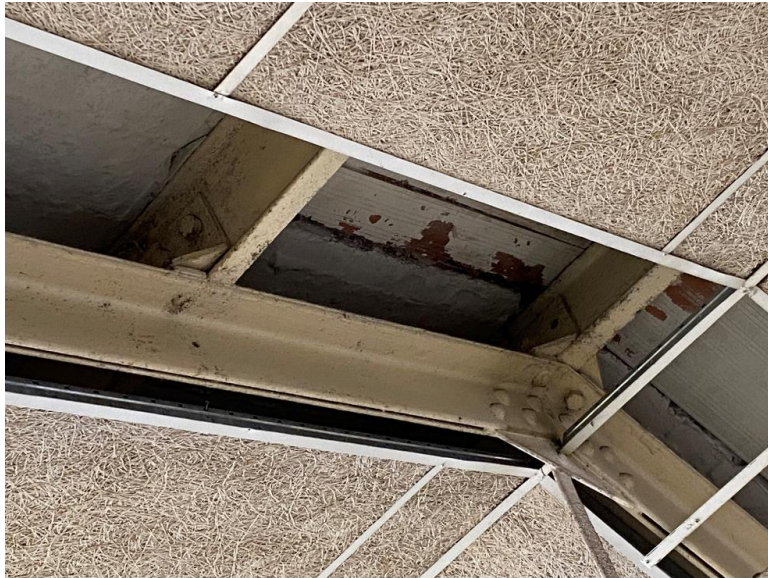
Il·lustració 7.- Cordó superior de l'encavallada
