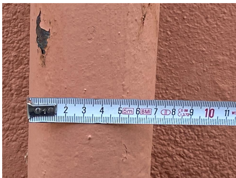
Il·lustració 26.- dimensions del baixant exterior
