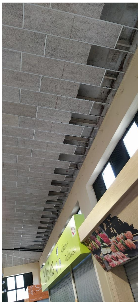
Il·lustració 9. - plaques de fals sostre retirades
