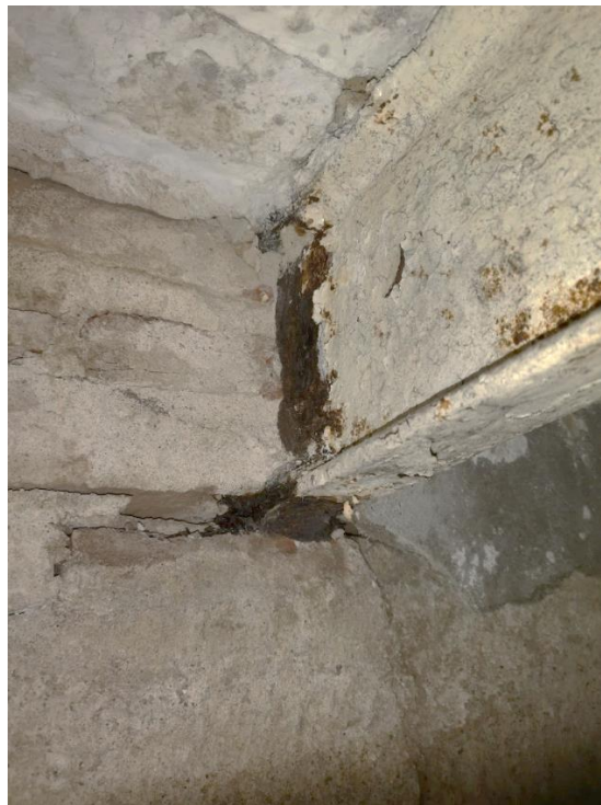
Il·lustració 12.- cap de bigueta oxidat
