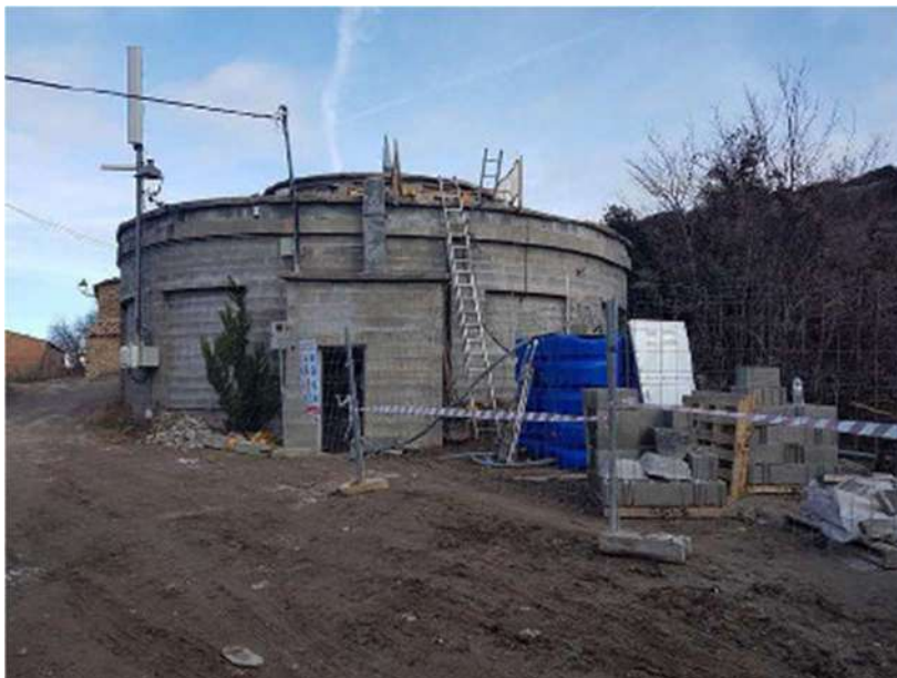
Imatge 4. Dipòsit d'Aransís durant la seva construcció.
