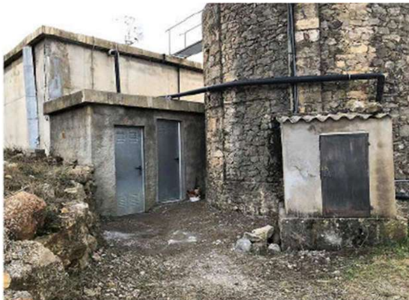
Imatge 5. Dipòsit de Sant Salvador de Toló.
