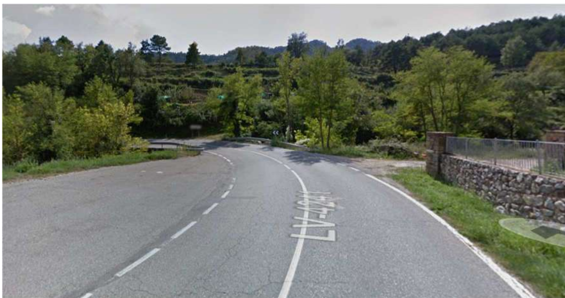
Final de l'actuació i inici de la via verda
