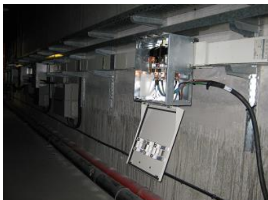
Foto 1. Cuadro de conexiones eléctricas abiertos con embarrado al descubierto en alguna galería transversal.
