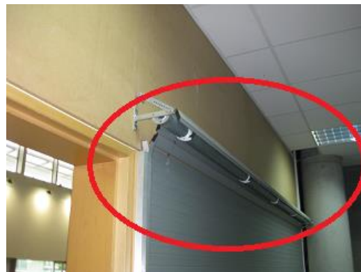
Foto 1. Engranajes persianas sala de información y guardarropas al descubierto en zonas de prensa y protocolo.
