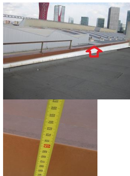
Foto 2. Muros de protección de cubreras a baja altura
