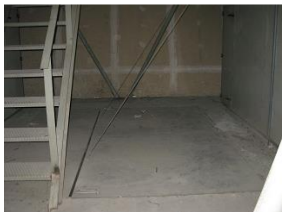
Foto 4. Trampilla de entrada de equipos en todas las salas técnicas sin líneas de vida o puntos de anclaje para uso de arnés de seguridad.
