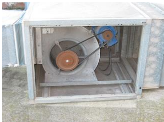
Foto 1. Engranajes de motor desprotegido
