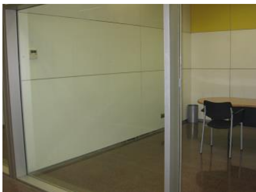
Foto 3. Tabiques acristalados como sistema de división de salas sin señalización o barrera que impida contacto con ello.
