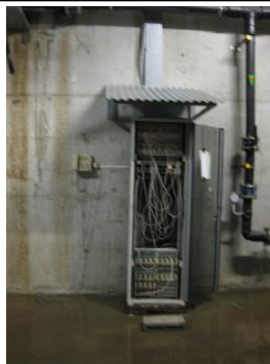
Foto 4. Equipos de telecomunicaciones con conexiones eléctricas en zonas con acumulación de agua.
