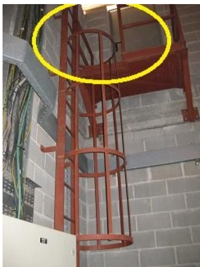
Foto 1. Desembarco desde escala a cubierta sin protección perimetral sobre la superficie de llegada.
