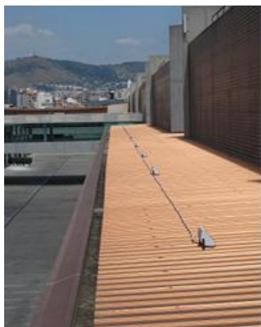
Foto 3. En mantenimiento de luminarias en Cubierta lateral (Rambla 3-2) sin protección perimetral.
