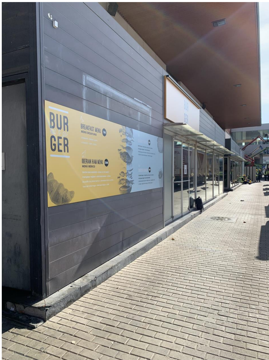
Estat actual façana mòduls restaurant
