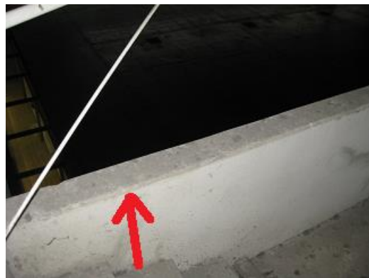
Foto 6. Muro perimetral en altillo lado CC3, en zona escalera con altura inferior a 90 cm.
