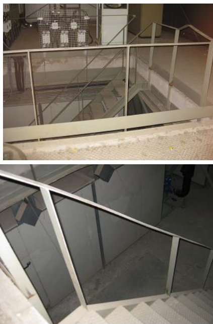
Foto 3. Salas técnicas en acceso a zona de máquinas sin barra intermedia y rodapiés en escaleras
