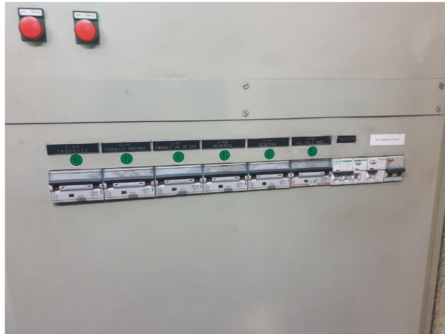
Armari circuits no crítics
