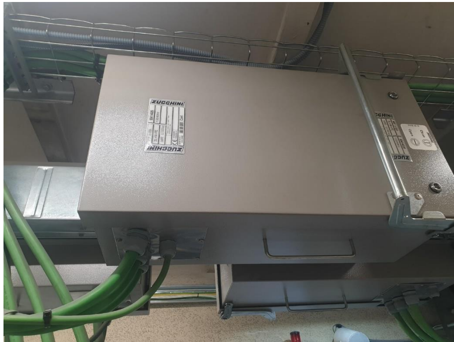
Sistema de connexió blindo barra zucchini
