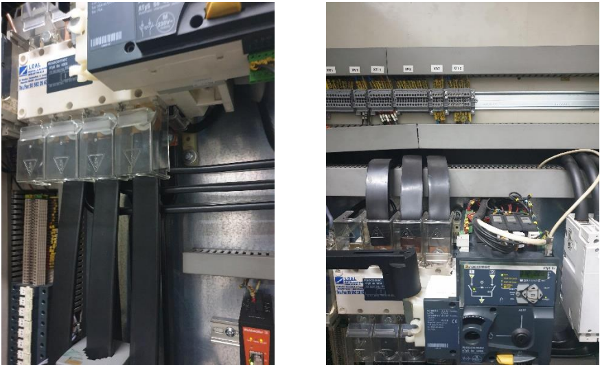
Commutació ATySp actual, amb la seva corresponent sortida amb barres de coure flexibles
