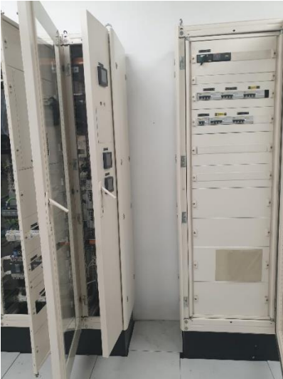
Espai per al nou quadre elèctric
