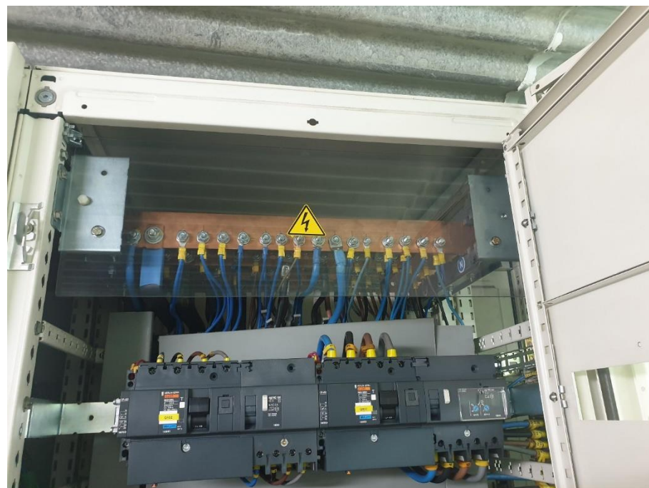
Barres Cu armari commutació 6kV - CIA
