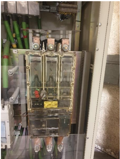
Interruptor escomesa FGC amb la línia de sortida a l'armari NC
