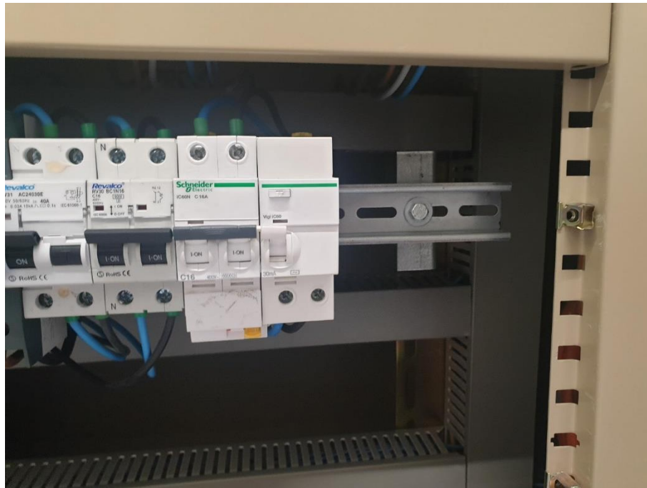
Espais i reserves en armariis crítics
