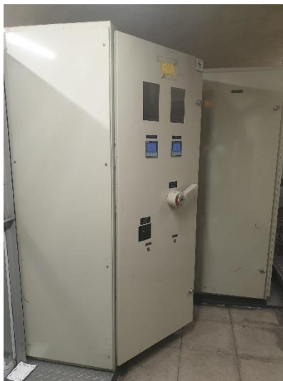
Armari elèctric amb els interruptors de capçalera i la commutació
