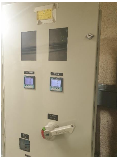
Armari elèctric amb els interruptors de capçalera i la commutació
