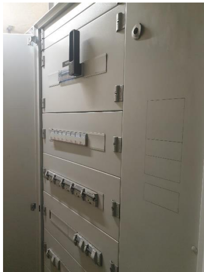
Seccionador i armari consums NC actuals
