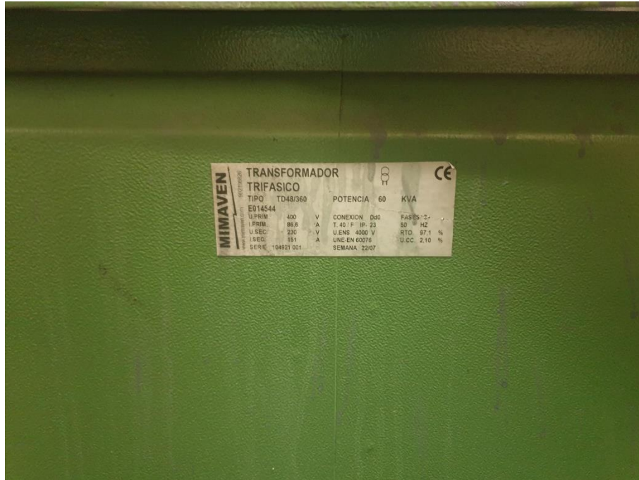
Característiques TRF existent 230/400V
