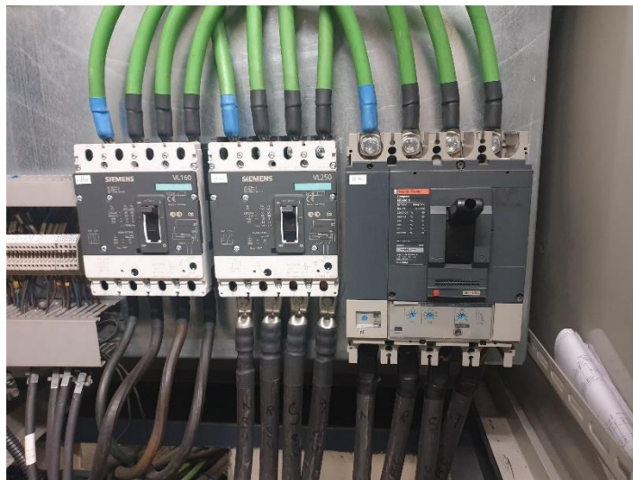
Imatges de les proteccions d'arribada de les línies de companyia i de la xarxa interna
