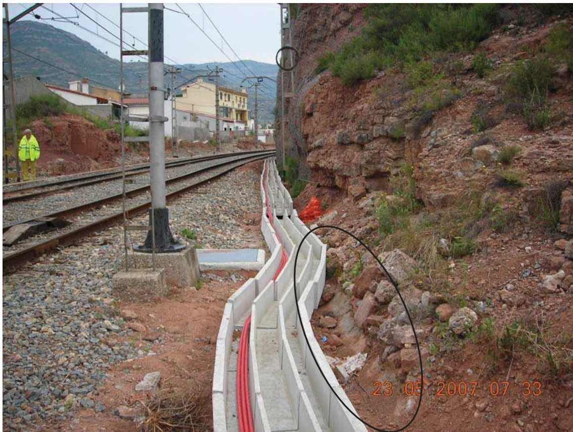
Figura 3.7 Exemple de cuneta tapada per la canalització de cablejat.
