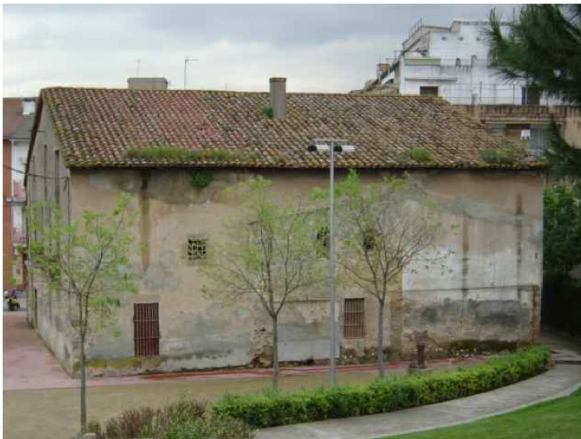
Vista de la façana nord abans de la fase I de rehabilitació
