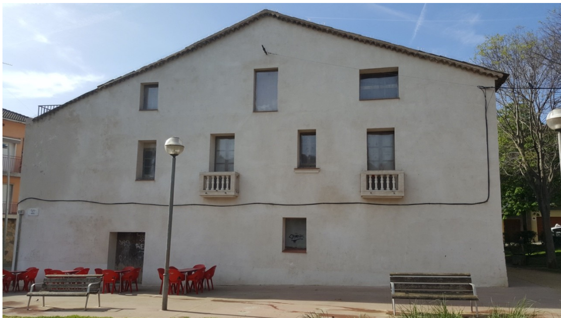
Vista de la façana nord després de la fase I de rehabilitació
