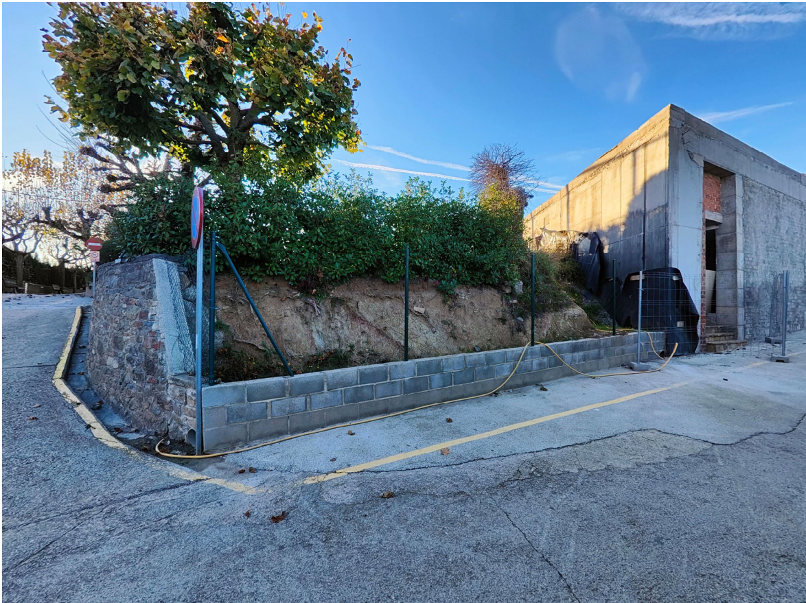
Part sud del magatzem de la brigada municipal.
