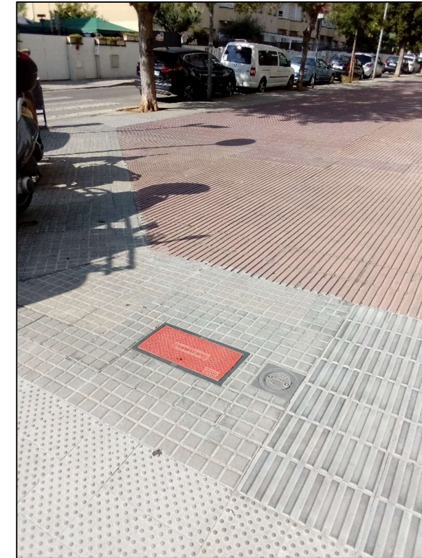
Figura 6. Xamfrà nord-oest entre els carrers Consell de Cent i Pau Casals. Vista d'hidrant existent.
