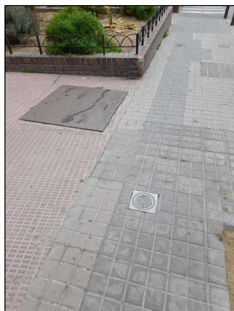
Figura 5. Punt de connexió de nova conducció amb instal·lació existent del pou.
