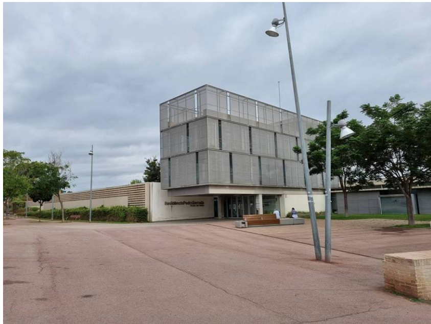
Imatge general de l'edifici
