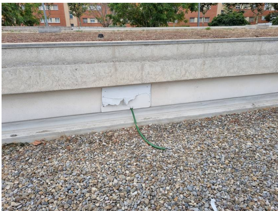
Sortida de les safates provisionals interiors per recollir l'aigua filtrada a l'interior de l'edifici (Fora d'àmbit del projecte)
