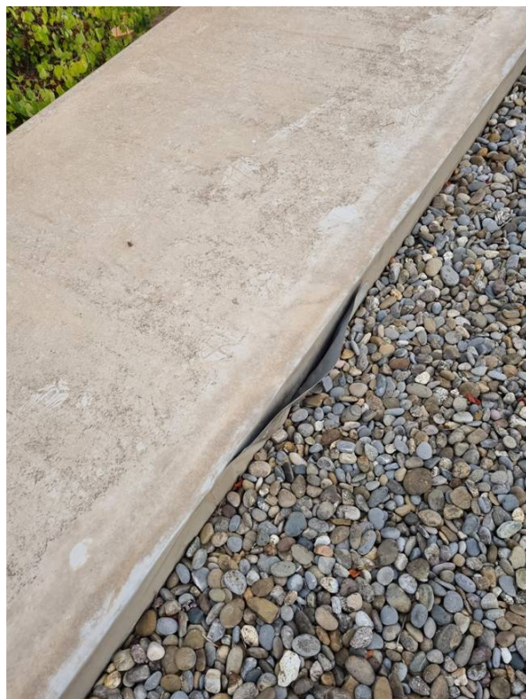
Punt susceptible d'entrada d'aigua
