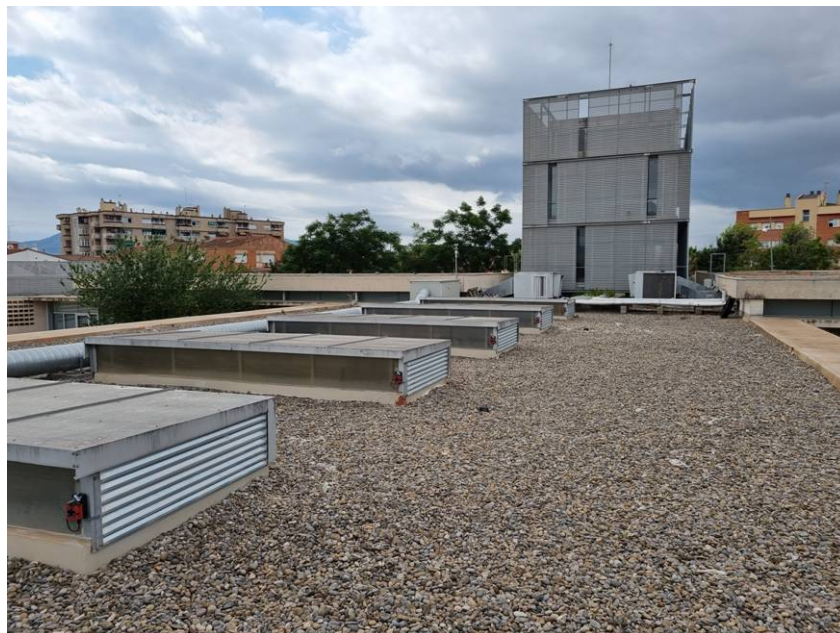
Imatge general de la coberta
