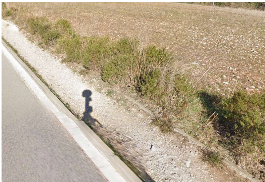
Imatge 1. Aspecte del tram on cal desbrossar i retirar la vegetació i terra dels marges interns
