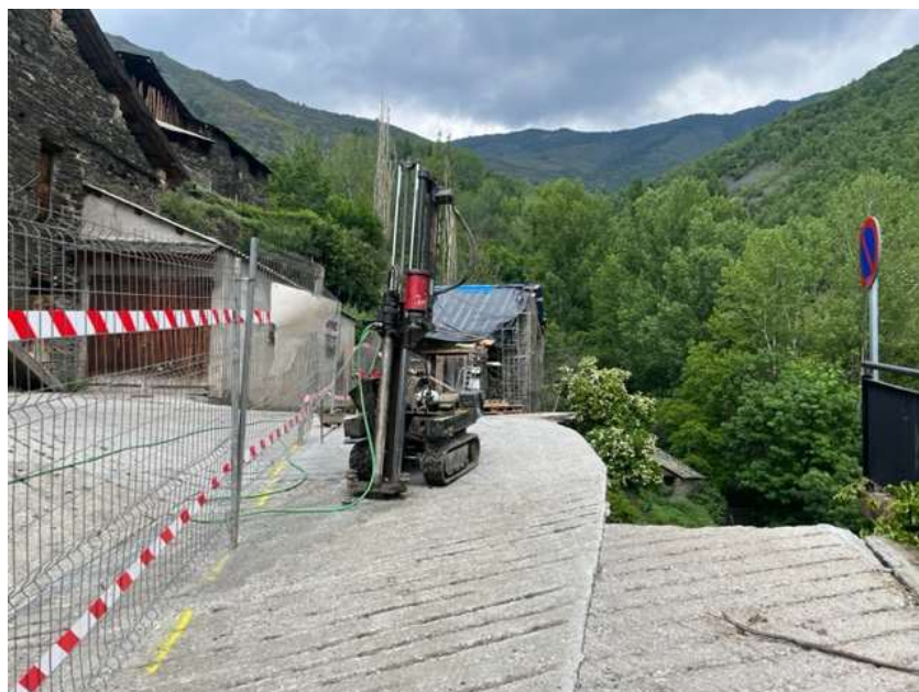
Situació i execució del penetròmetre 3.
