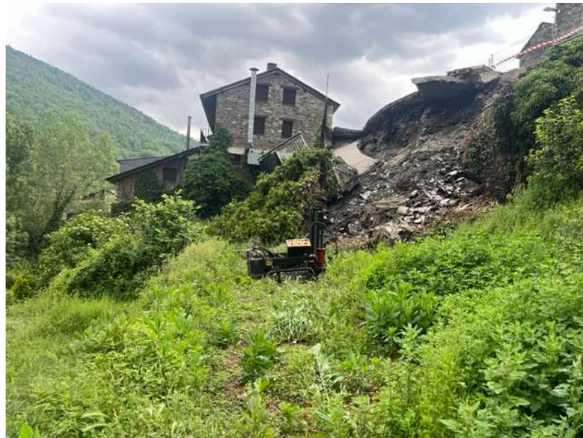
Situació i execució del penetròmetre 1.
