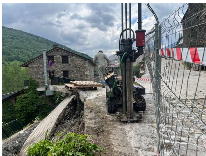
Situació i execució del penetròmetre 2.
