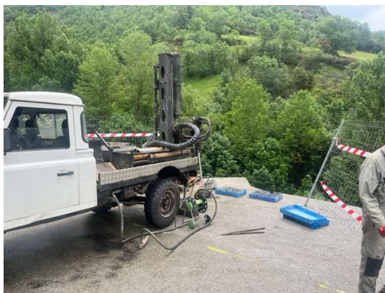
Situació i execució del sondeig 1.
