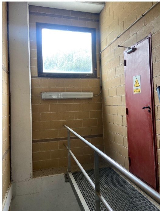
Imatge 2.- Passadís d'entrada a la sala de quadres elèctrics centrífugues EDAR Arenys.
