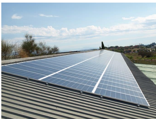
Instal·lació coplanar a coberta de xapa
