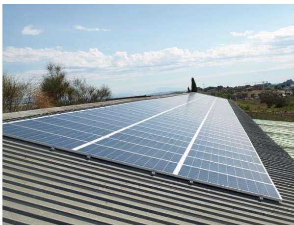
Instal·lació coplanar a coberta de xapa
