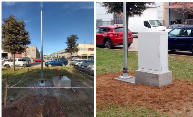
Figura 8. Exemple de construcció del dau-arqueta. A) (esquerra) aspecte un cop l'arqueta s'ha cimentat on s'aprecia el tub corrugat que enllaçarà la base del màstil amb l'interior de l'armari. B) (dreta) el muntatge acabat amb l'armari col·locat i ancorat a l'arqueta.
