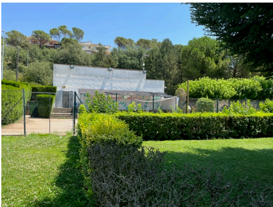
Fig. 4- Vista de l'edifici de vestidors existent (est)
