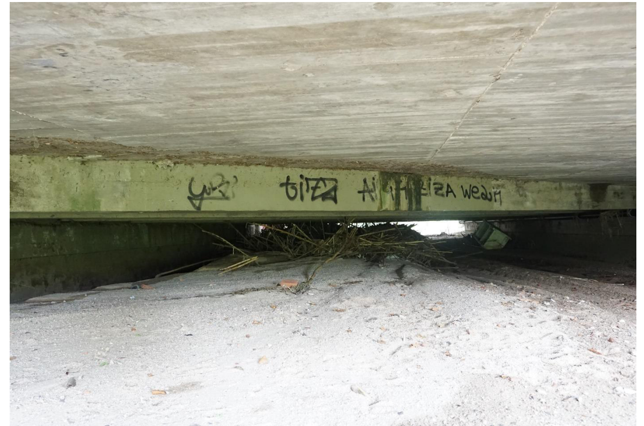
Figura 2. Vista de l'estat actual de l'obra de pas.
