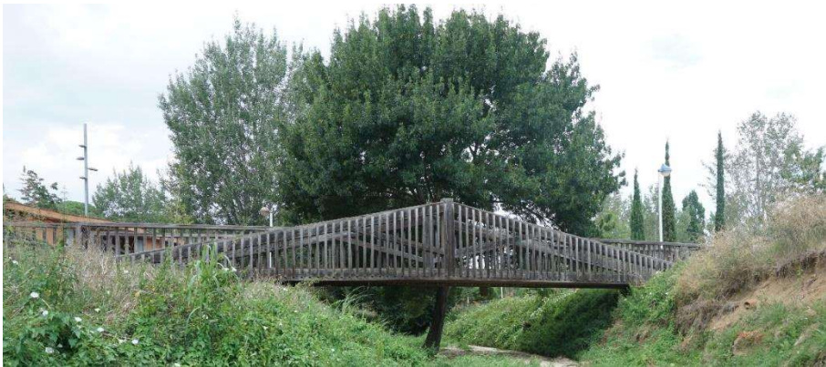
Figura 1. Passarel·la a desmuntar per als treballs de reforç de talussos.
