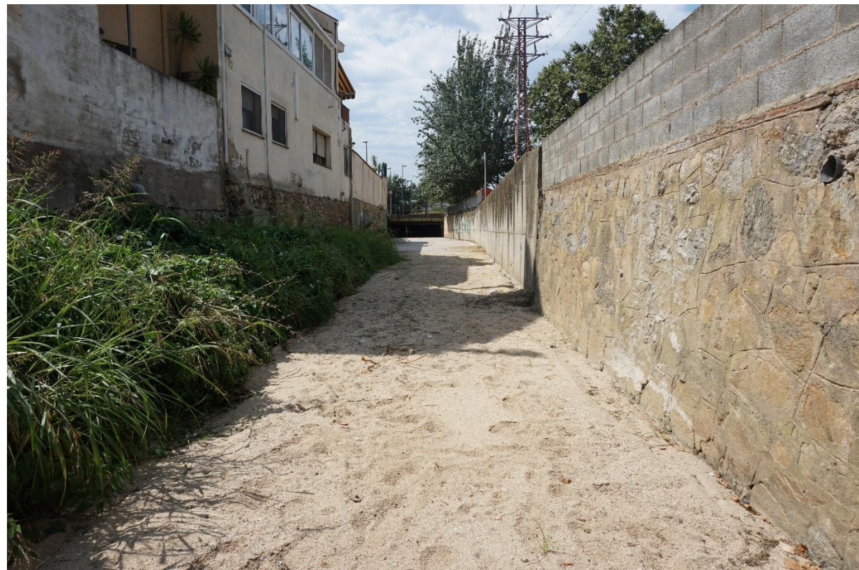
Figura 21. Zona de transició entre la zona d'estudi i el tram soterrat de la Riera.
