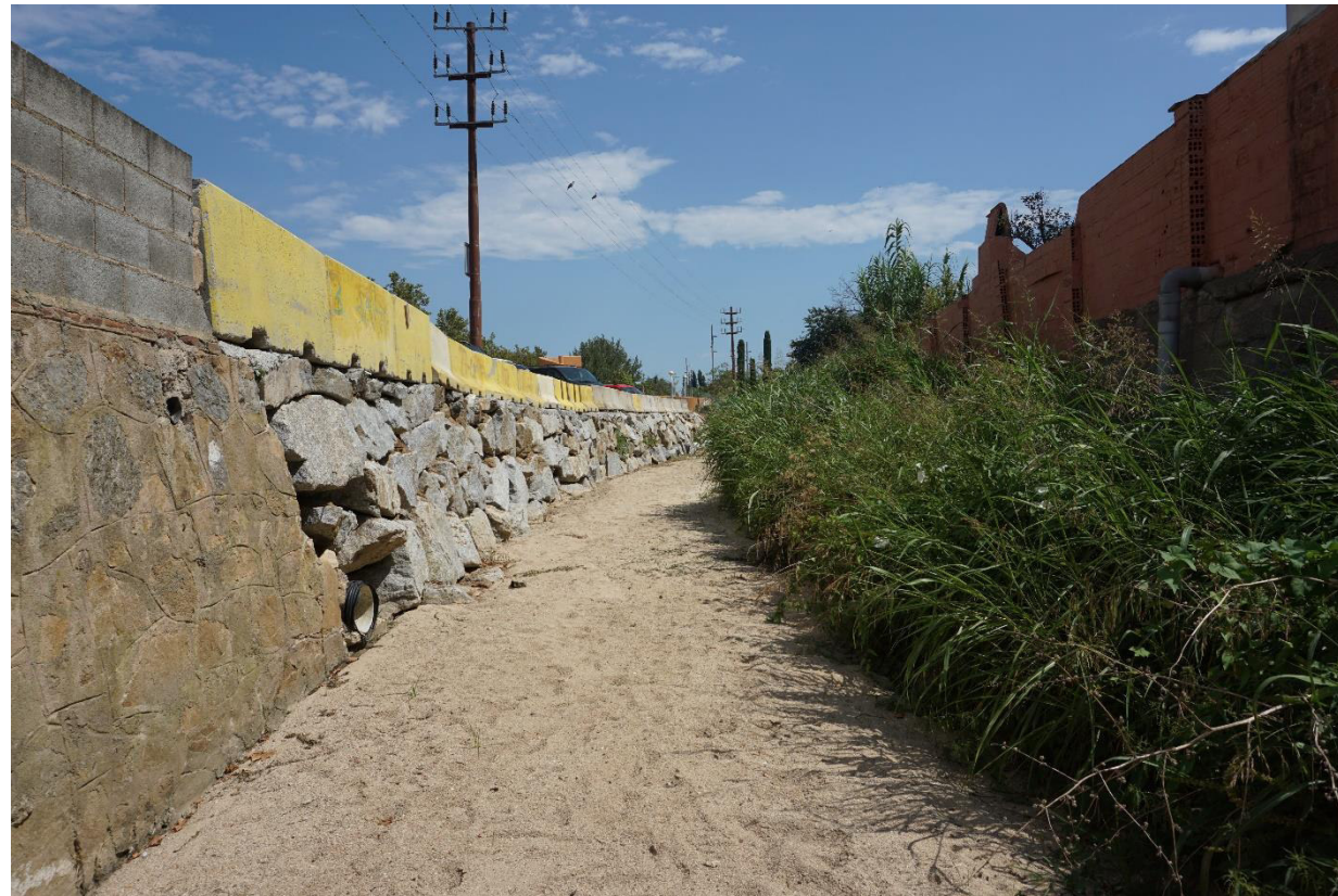
Figura 20. Tram final de l'àmbit d'estudi protegit amb escullera al marge dret de la Riera.
