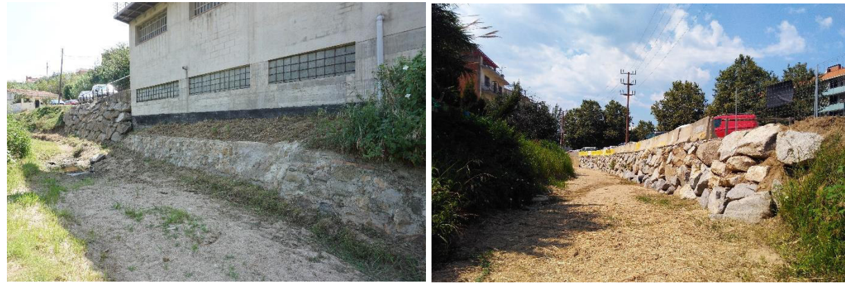
Figura 3. Tram de la Riera protegides amb escullera.
