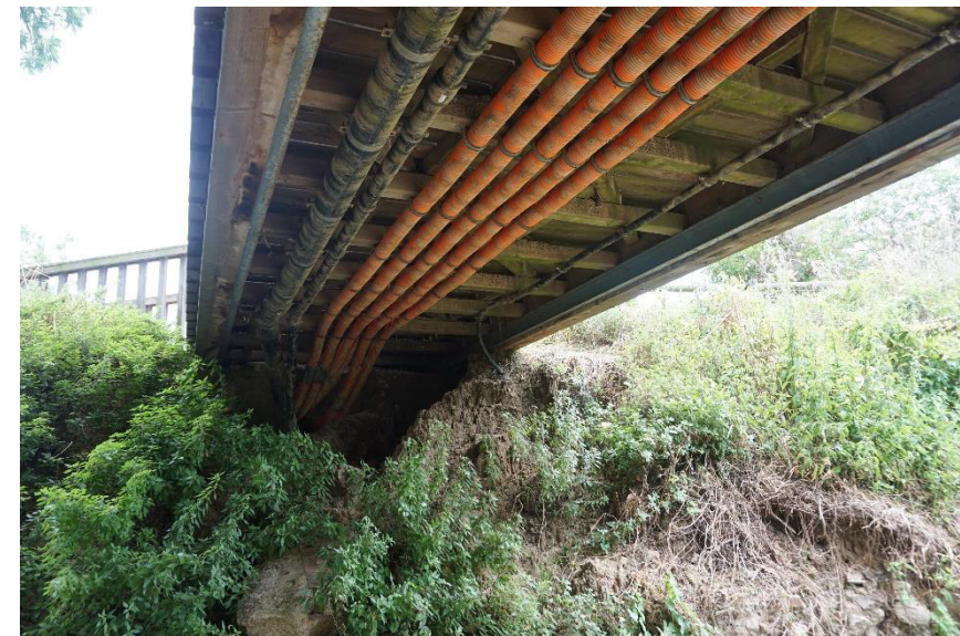
Figura 11. Serveis de reg i d'enllumenat públic sota el pont de fusta.
