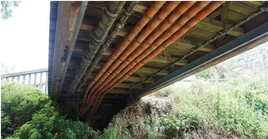
Figura 2. Serveis a protegir un cop desmuntada la passarel·la.
