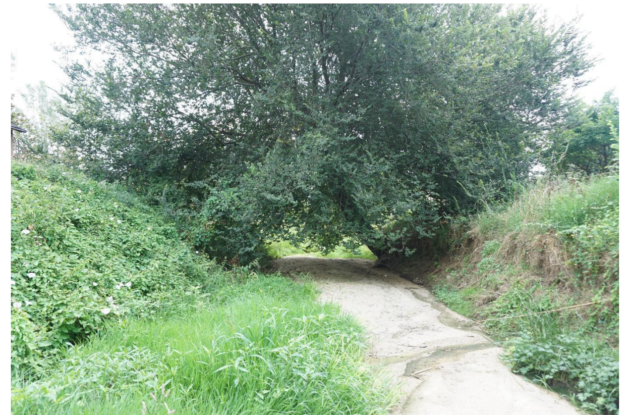
Figura 3. Vista de la llera de la Riera a la part inicial del tram d'estudi.
