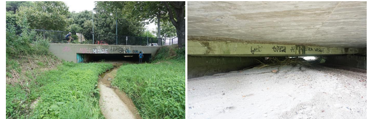
Figura 1. Obra de pas sota Avinguda de la Costa Brava (esquerra) i aspecte inferior de la mateixa (dreta).
