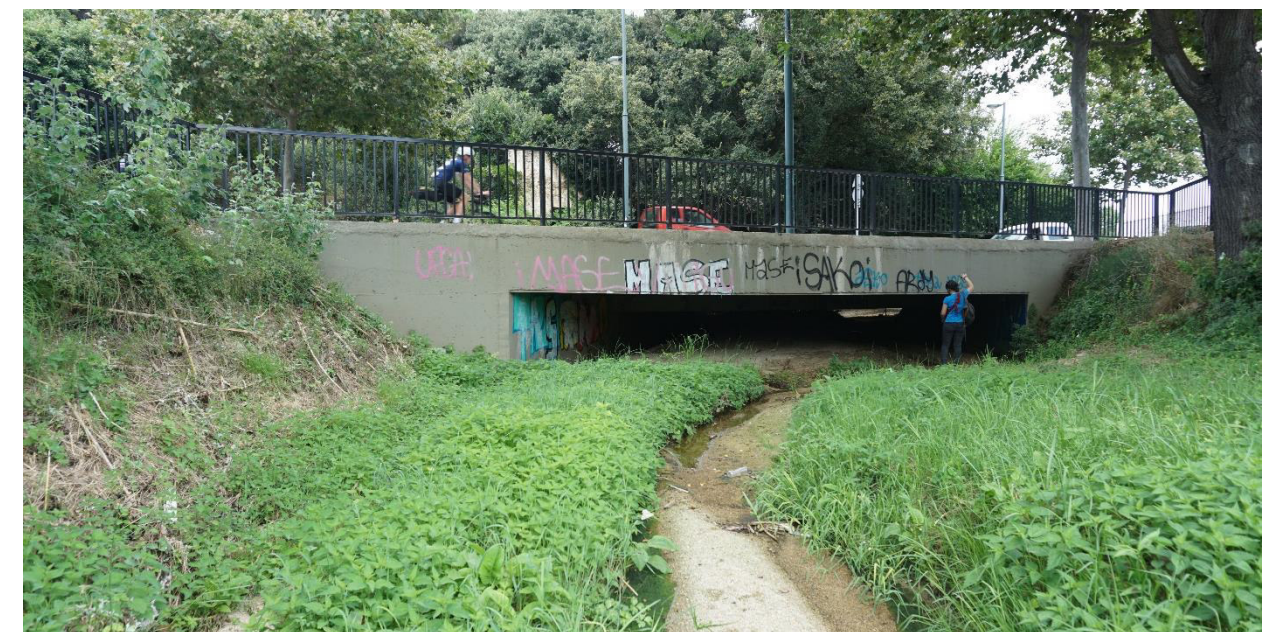
Figura 2. Obra de drenatge al creuament amb l'Avinguda de la Costa Brava (inici del tram d'estudi).
