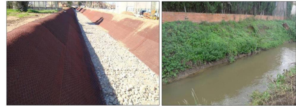
Figura 4. Fotografies de les Obres de la Sèquia de Vinyals després de la instal·lació i passats tres mesos (ACA)
