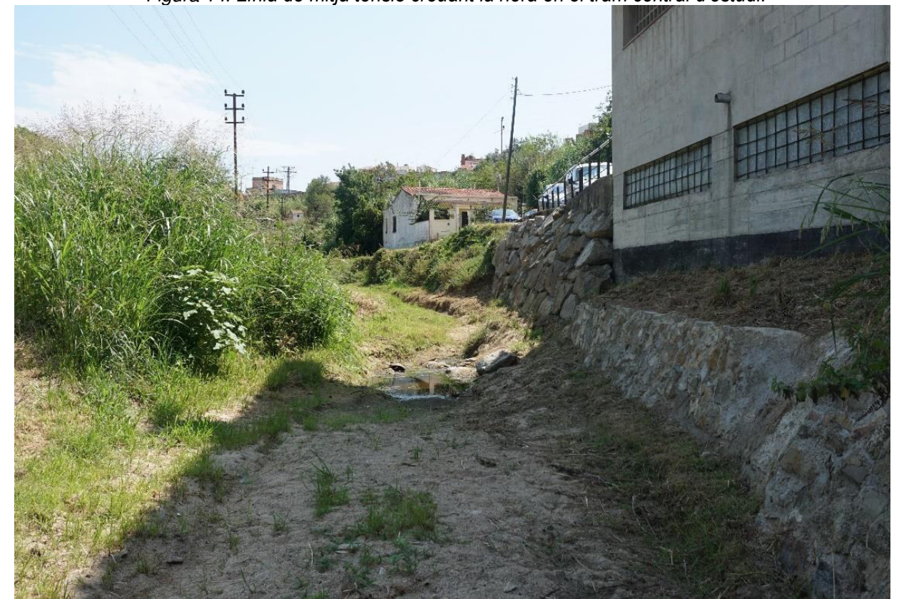
Figura 15. Llera de la Riera de Palafolls, on el marge esquerre es troba protegit amb escullera.
