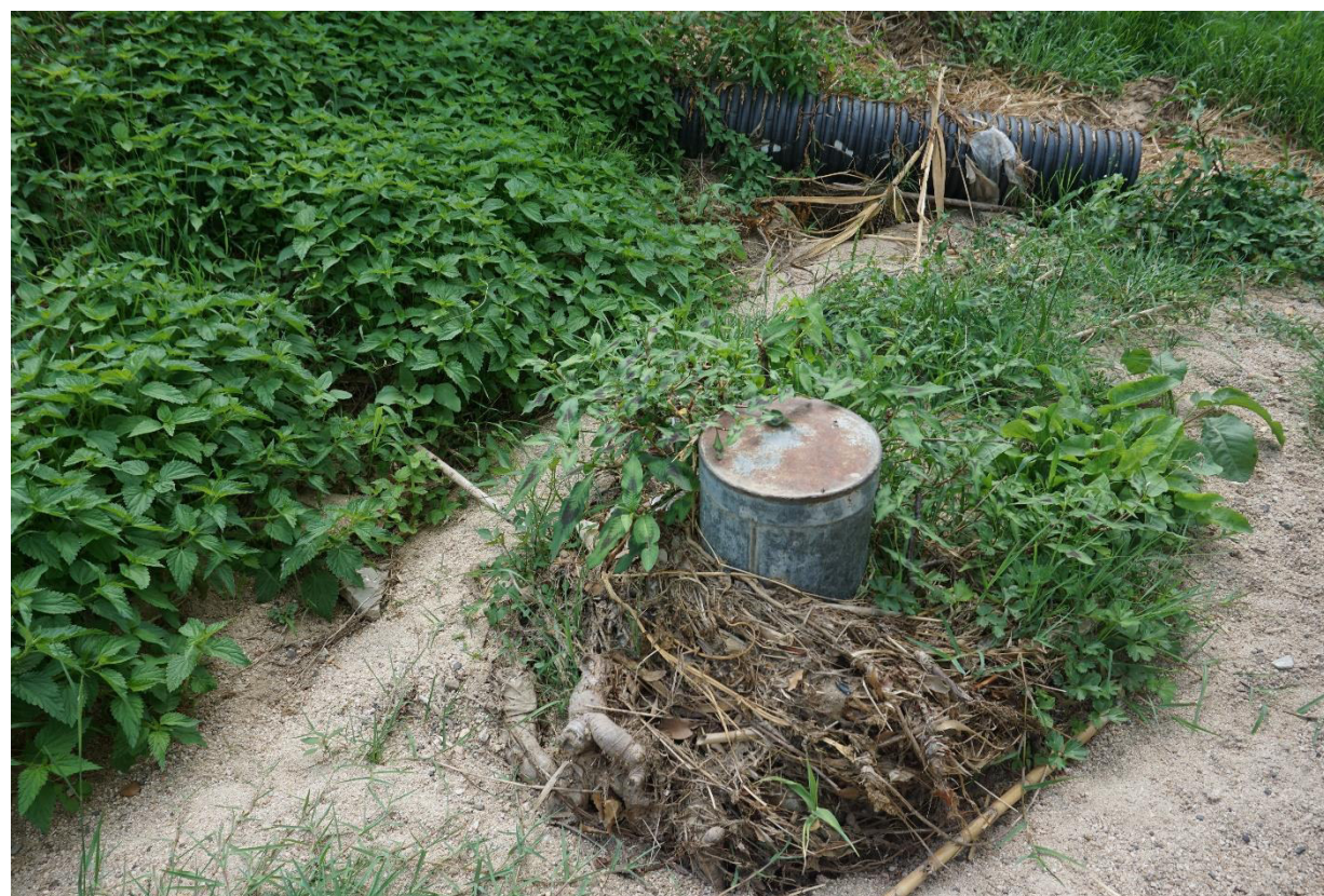
Figura 9. Abocament de la xarxa de pluvials i pou d'aigua
