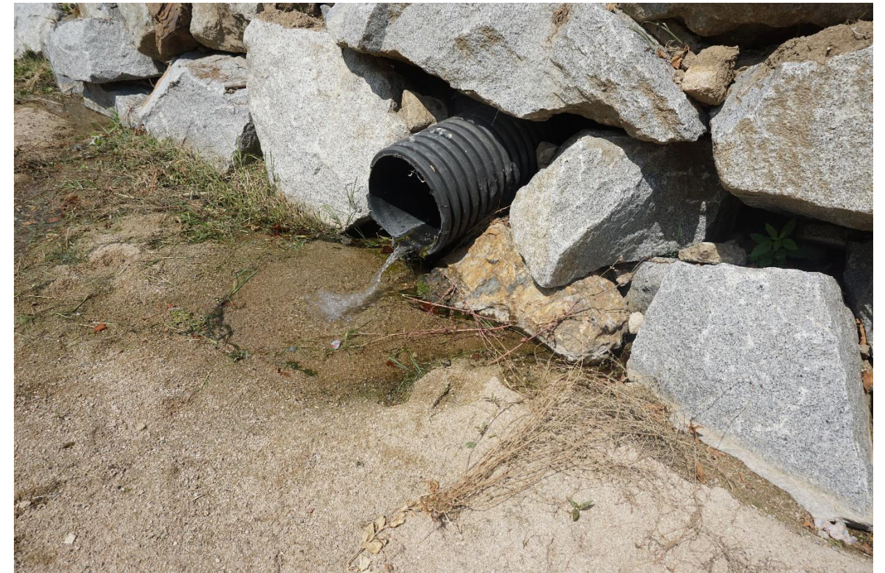
Figura 18. Abocament de la xarxa d'aigües pluvials.
