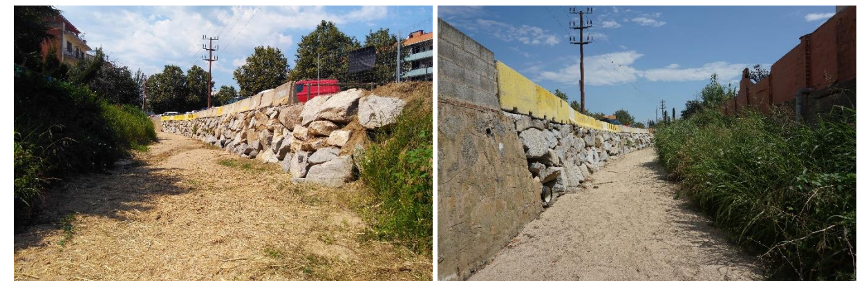
Figura 3. Aspecte del tram final a endegar.
