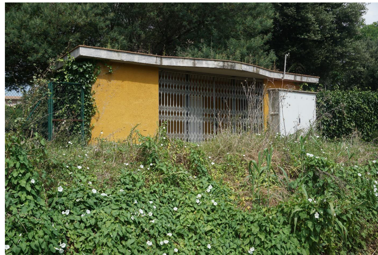
Figura 10. Caseta de quadres de comandament per al reg del parc i quadre elèctric de la instal·lació elèctrica del parc.
