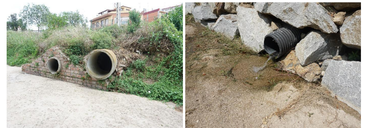
Figura 7. Abocaments de la xarxa d'aigües pluvials
