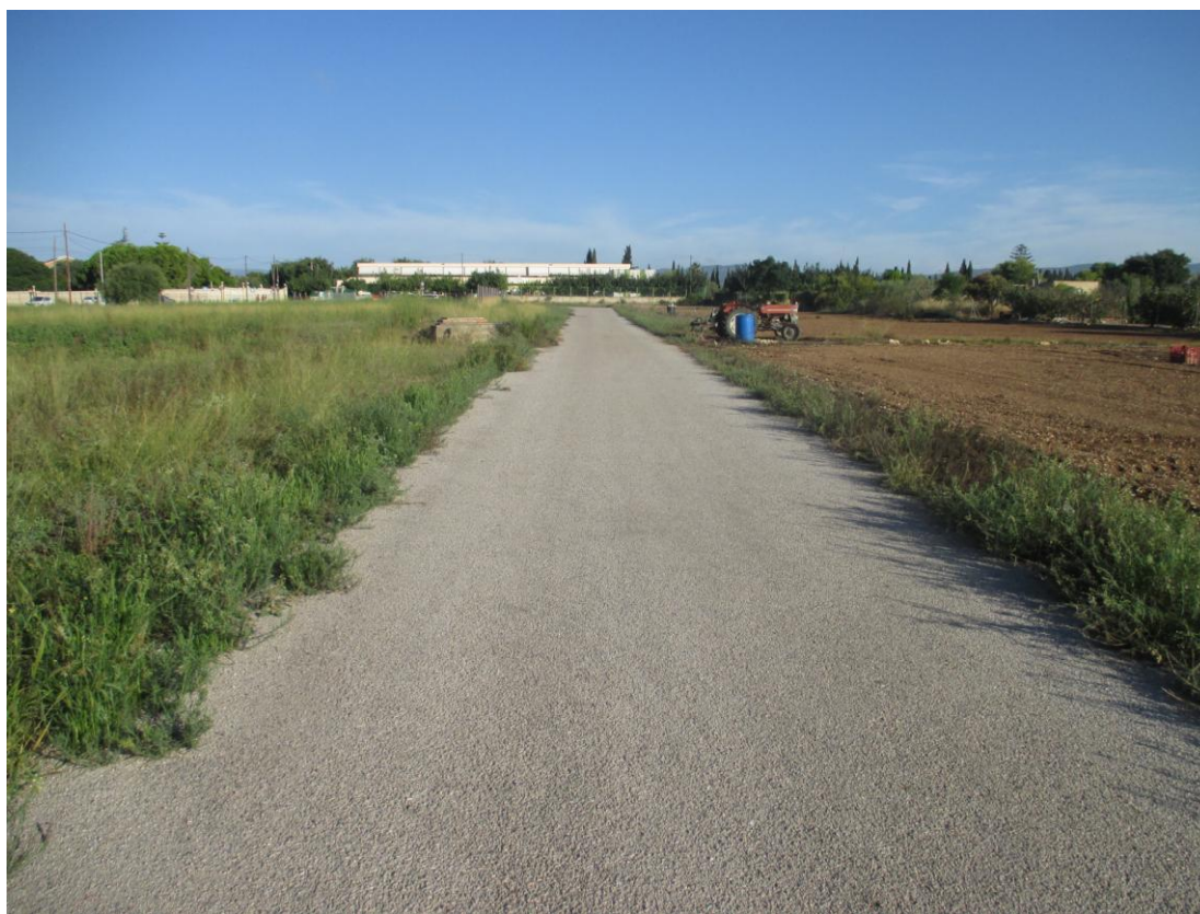
Carrer de Gas en sol NO urbà
