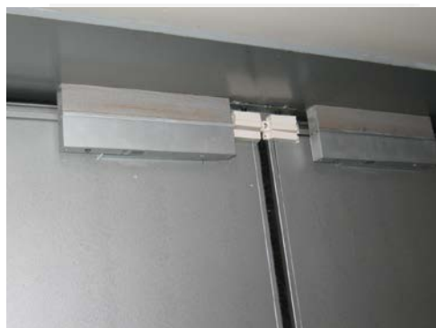
Foto 1: Imants de retenció i sensors d'obertura
