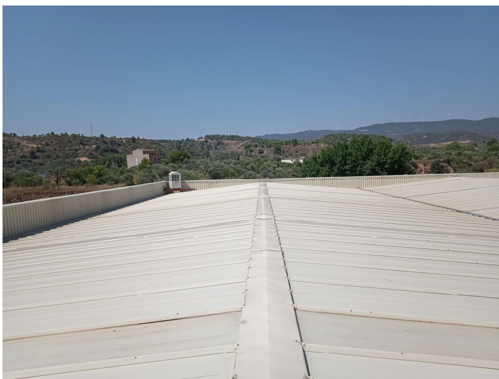
Imatges de coberta de la nau
