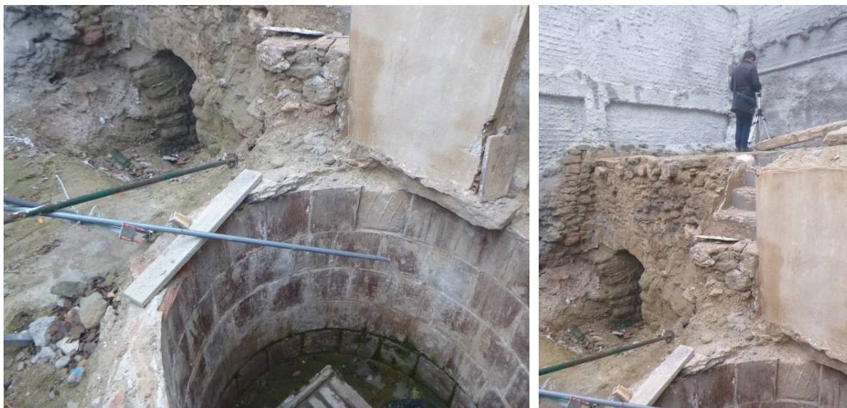
Vistes dels 3 nivells existents
