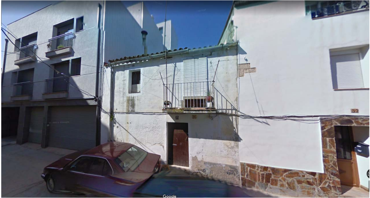
Immoble situat al carrer Major núm.35, abans del seu enderroc. Imatge Street View de l'any 2010
