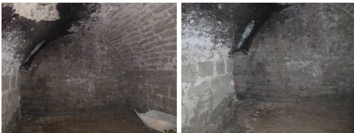
Vista vers l'accés al soterrani
