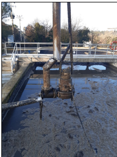
Il·lustració 2: Exemple aerojet Flygt que s'ha de traslladar de l'EDAR de Caldes de Malavella a l'EDAR d'Aiguaviva Park
