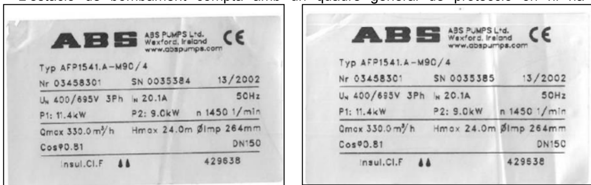
Il·lustració 3: Placa de característiques de les bombes instal·lades actualment
