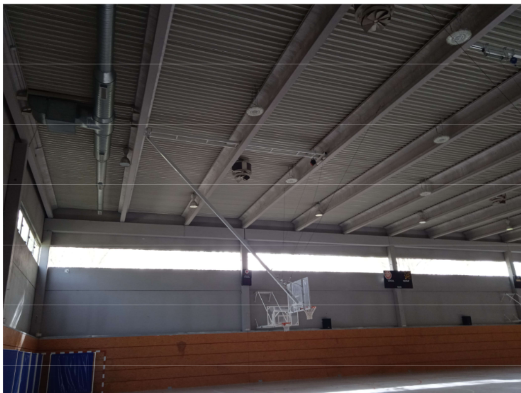
Imatge de l'estructura de la coberta del pavelló
