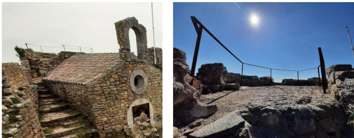
Figs. 15 i 16.- Imatges en la qual s'aprecia l'impacte de les baranes i les seves escasses condicions de protecció enfront de caigudes.
