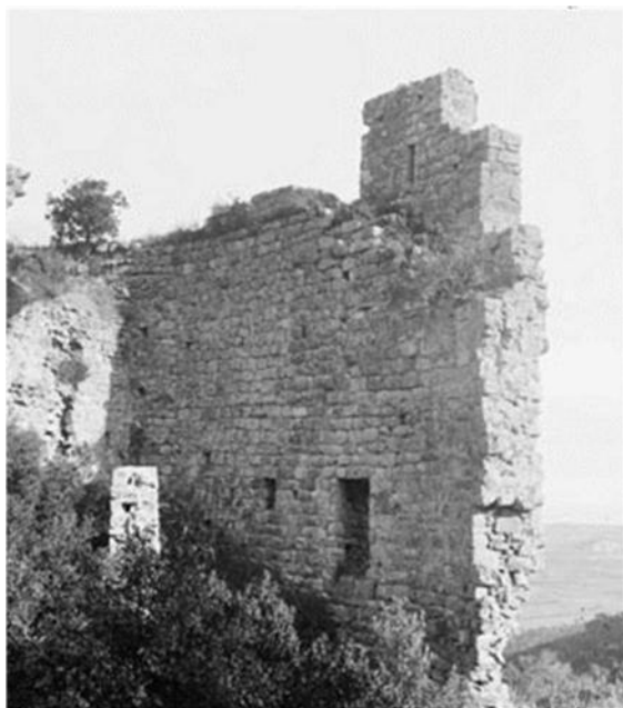
Figs. 9 i 10.- Imatge interior del llenç sud-est prèvia a la consolidació de fàbriques i imatge de l'estat actual en la qual es pot distingir l'estratigrafia més recent.
