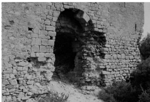
Figs. 11 i 12. Imatge de l'alçat exterior del llenç sud-oest del RSa1 en el qual es pot apreciar l'estat previ i posterior a la intervenció de restauració del buit d'accés principal al recinte Sobirà.
