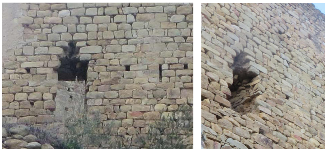
Figs. 7 i 8.- Imatges del mateix buit-finestra anterior del llenç sud-est de l'àrea RSa1 però vist des de la cara exterior.
