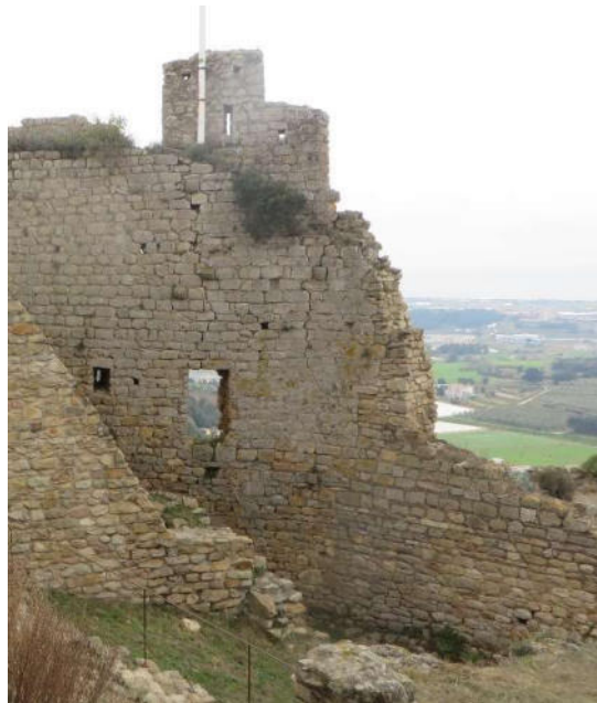
Figs. 9 i 10.- Imatge interior del llenç sud-est prèvia a la consolidació de fàbriques i imatge de l'estat actual en la qual es pot distingir l'estratigrafia més recent.
